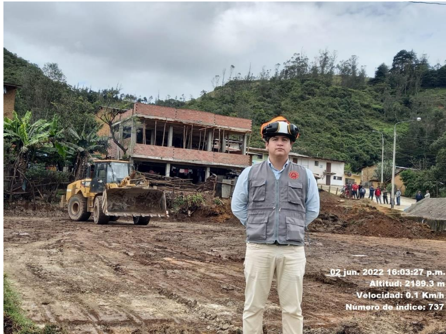
Ilustración 1. Visita laboral para la construcción de un parque de recreación pública en el Barrio Yumbe, Distrito de Huarmaca, 2022
