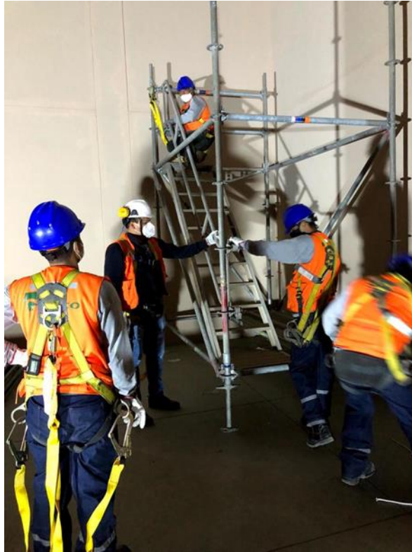
Figura 17. Capacitación en armados de andamios normados
