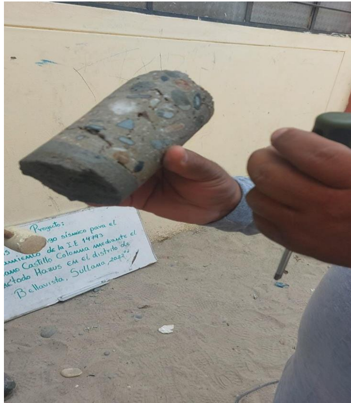
Muestra del concreto de la columna C-1.
