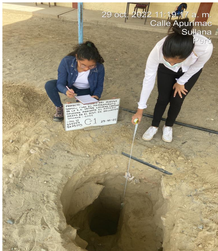
Calicata de 0.90x3m
