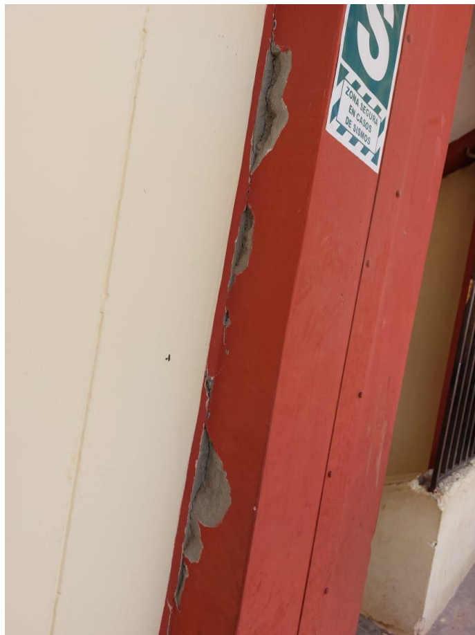
Situación actual de los elementos estructurales del Pabellón A.
