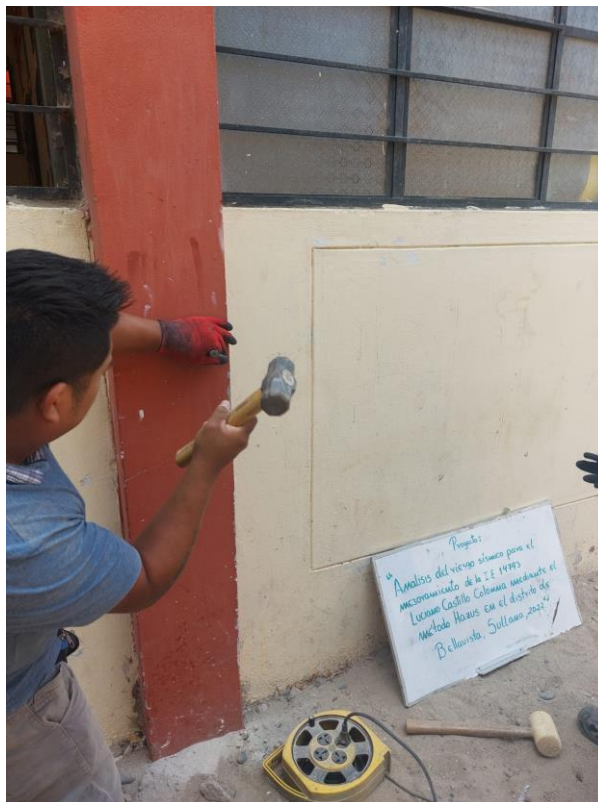
Ingreso de los pernos de expansión para sujetar la base.
