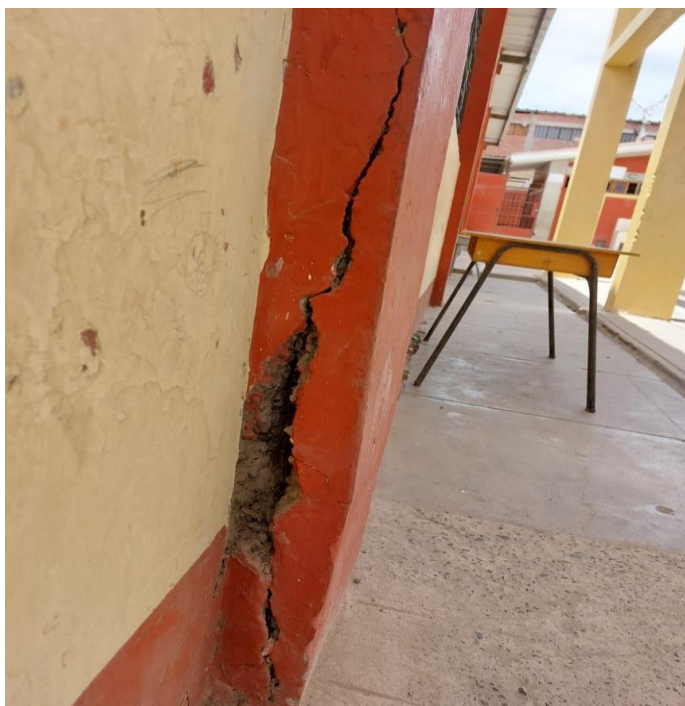
Situación actual de los elementos estructurales del Pabellón A.
