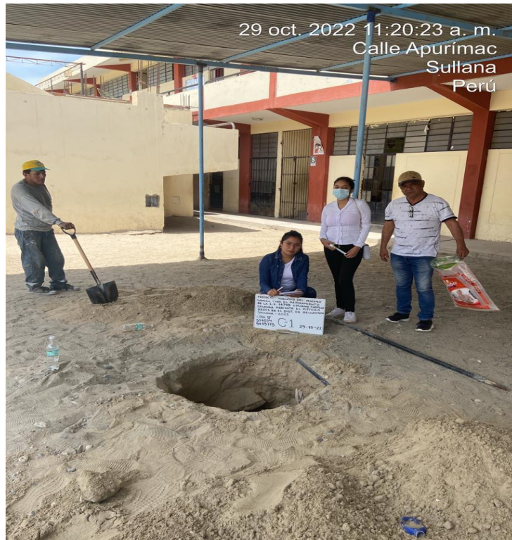
Calicata C1 para evaluar las características del terreno en estudio.
