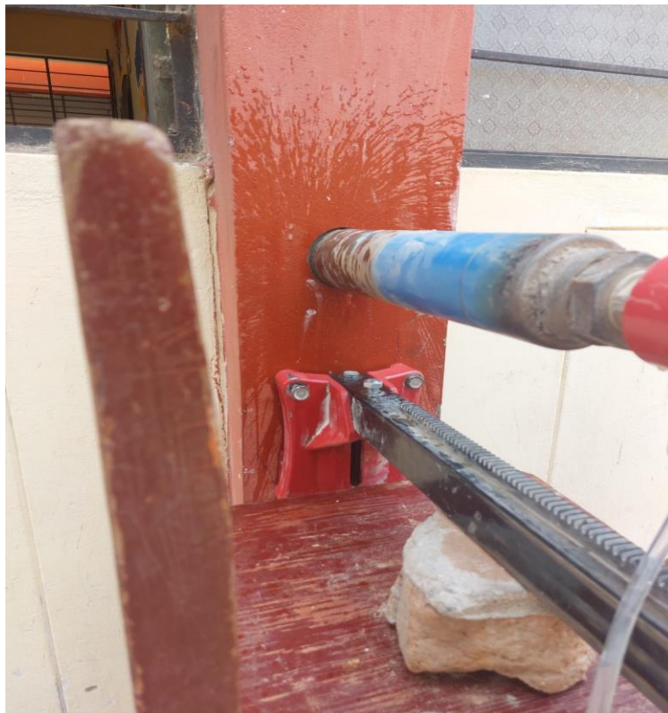
Diamantina perforando a la columna C-1.
