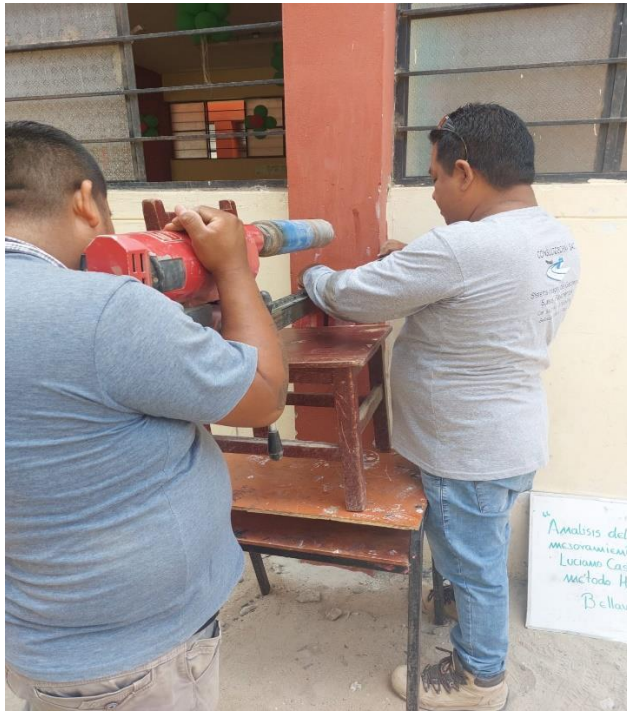
Ensayo de diamantina a la columna C-1.
