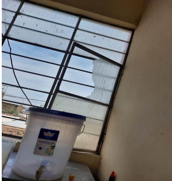
Situación actual de las ventanas de la sección A del Pabellón A.
