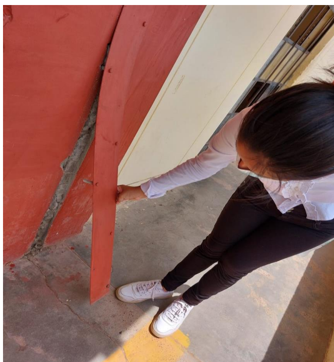
Situación actual de los elementos estructurales del Pabellón A.
