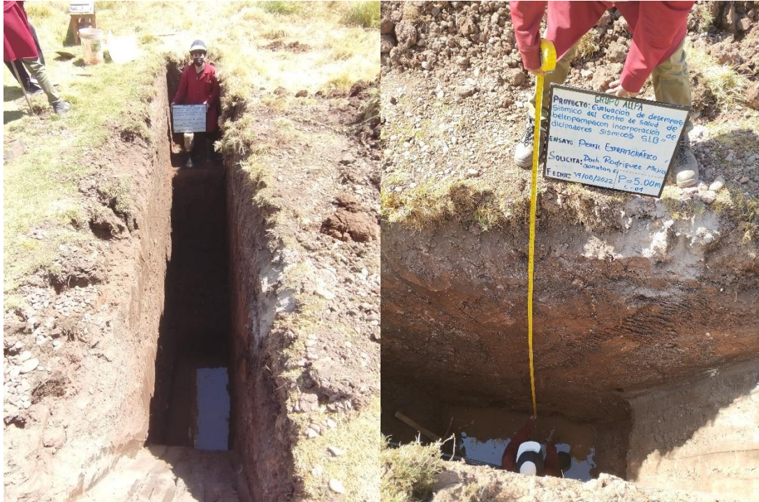
Figura. Excavación y exploración del suelo
