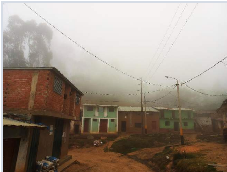
Figura 4. Uyurpampa – Marayhuaca: el clima en la zona muchas veces es frío y lluvioso, presentando en ocasiones neblina muy densa, setiembre 2022.
