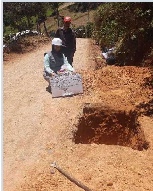
Figura 65. Estudio de mecánica de suelos del Diseño de infraestructura vial para mejorar la transitabilidad vehicular centros poblados Uyurpampa – Marayhuaca (0+000Km - 9+862Km) C2, setiembre 2022.
