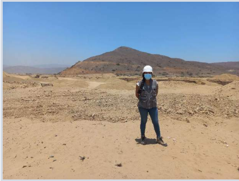
Figura 19. Cantera tres tomas: vista donde se aprecia material fino por explotar, setiembre de 2022.
