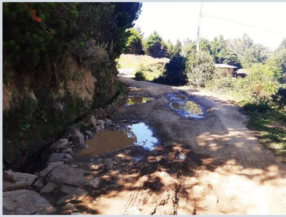
Figura 4. Uyurpampa-Marayhuaca: kilómetro 7+050 del tramo en estudio, donde se aprecia la trocha afectada por las lluvias, setiembre 2022.
