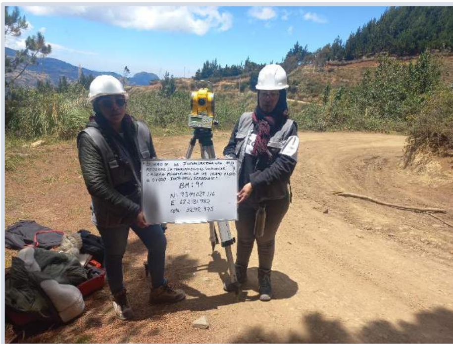
Figura 7. Levantamiento topográfico del Diseño de infraestructura vial para mejorar la transitabilidad vehicular centros poblados Uyurpampa – Marayhuaca (0+000Km - 9+862Km), Incahuasi - Ferreñafe, 2022, BM 91, setiembre 2022.
