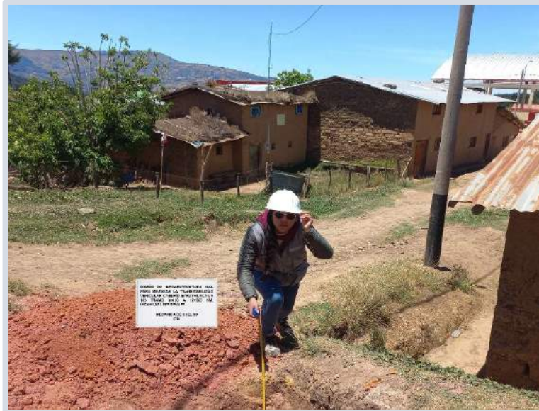
Figura 81. Estudio de mecánica de suelos del Diseño de infraestructura vial para mejorar la transitabilidad vehicular centros poblados Uyurpampa – Marayhuaca (0+000Km - 9+862Km) C19, setiembre 2022.
