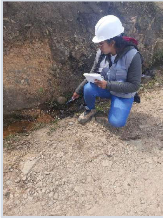
Figura 4. Uyurpampa – Marayhuaca: curso de agua contaminado, lo cual afecta también a la Carretera, ya que en el aumento del caudal esta se desborda, setiembre 2022.
