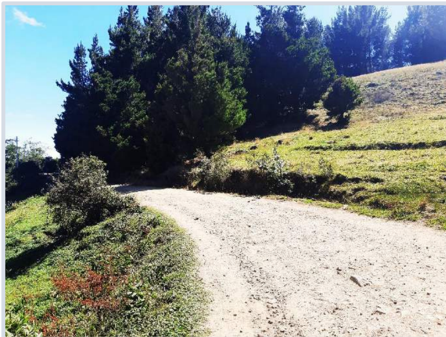
Figura 3. Uyurpampa-Marayhuaca: kilómetro 6+020 del tramo en estudio, donde se observa la trocha y la existencia de vegetación, setiembre 2022.
