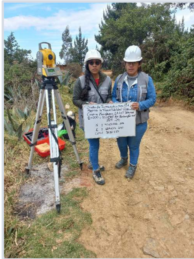
Figura 3. Levantamiento topográfico del Diseño de infraestructura vial para mejorar la transitabilidad vehicular centros poblados Uyurpampa – Marayhuaca (0+000Km - 9+862Km), Incahuasi - Ferreñafe, 2022, BM 20, setiembre 2022.
