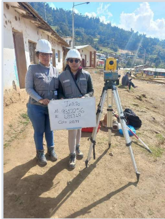
Figura 1. Levantamiento topográfico del Diseño de infraestructura vial para mejorar la transitabilidad vehicular centros poblados Uyurpampa – Marayhuaca (0+000Km - 9+862Km), Incahuasi - Ferreñafe, 2022, BM 1, setiembre 2022.
