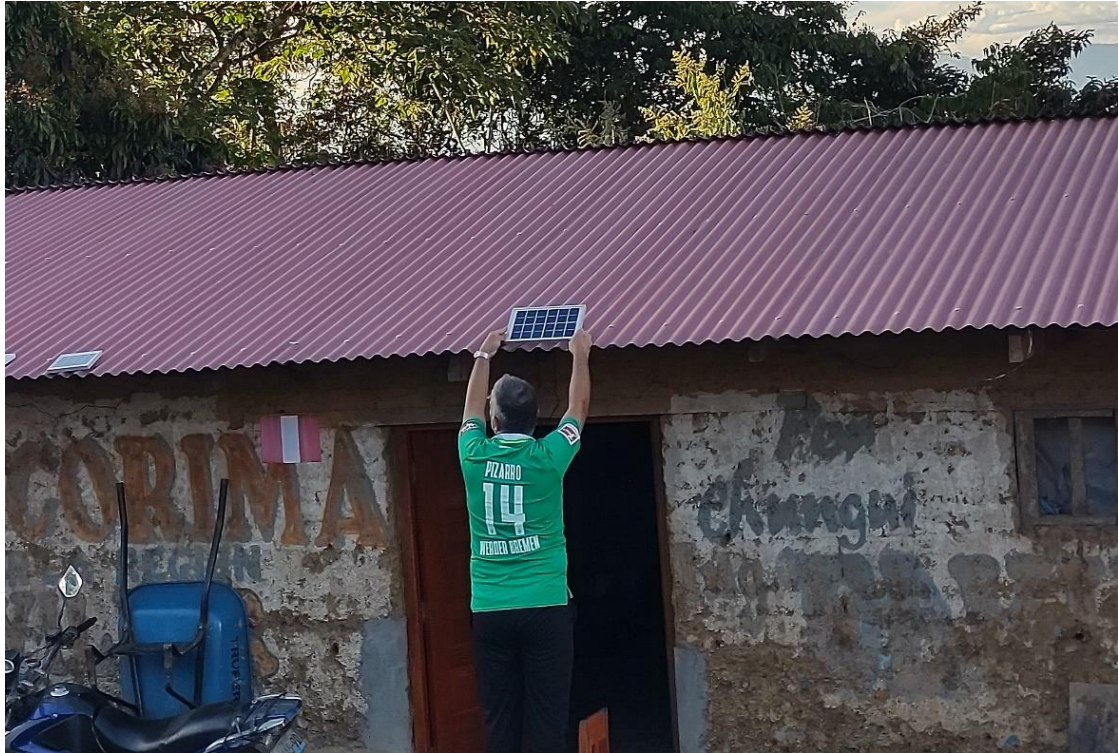
Figura 34.- Instalación de panel fotovoltaico - Comunidad de Malvinas
