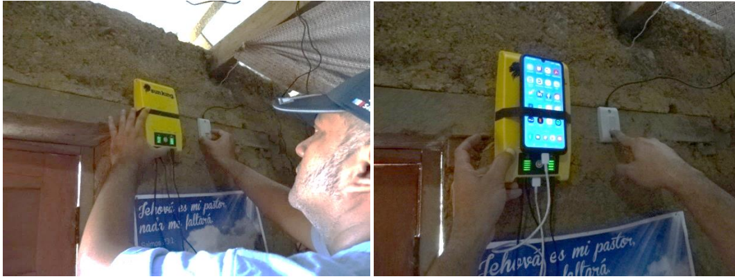
Figuras 36 y 37.- Instalación de panel de control - Comunidad de Malvinas
