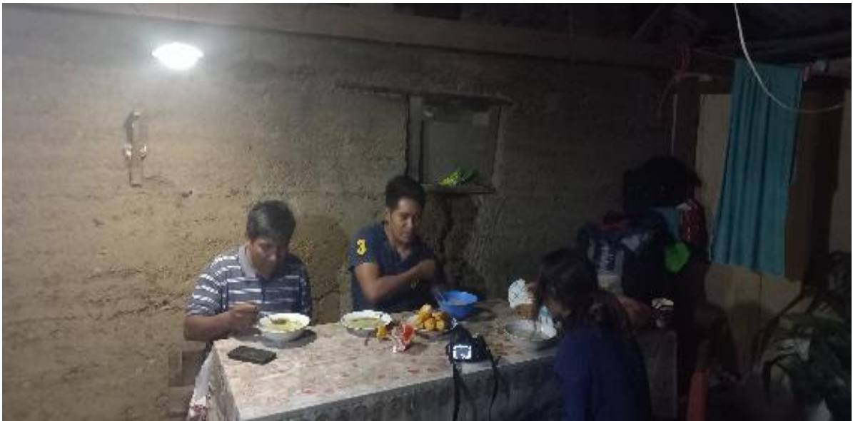
Figura 38.- Instalación de equipo fotovoltaico pug and play de tres luces de 60 lúmenes y doble puerto USB de 5V en Malvinas
