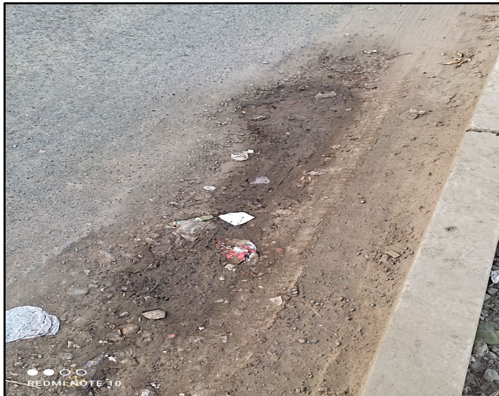
Figura 16 - Fisuras longitudinales de junta de construcción.
