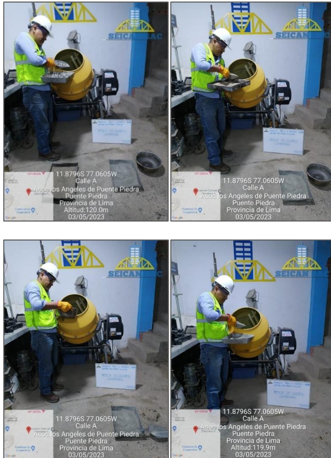
Figura 15. Preparación de concreto convencional
