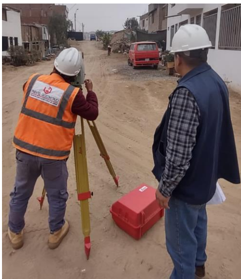
Figura 69. Calle Las Azucenas, se aprecia que no tienen veredas
