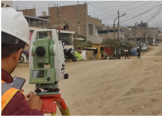
Figura 68. Calle Los Geranios, terreno irregular.
