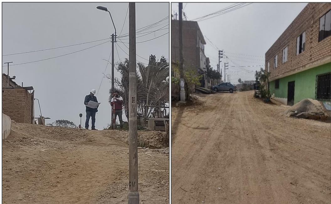
Figura 65. Trabajo preliminar de campo de topografía
