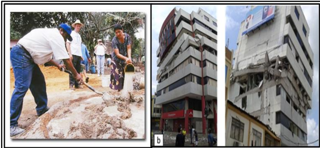
Figura 1. Errores de elaboración de concreto y fallas que se presentan. Fuente: https://bit.ly/3dirSis
