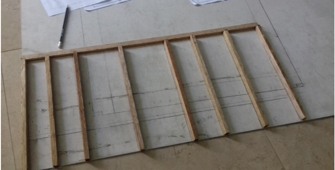
Figura N°5 Se realizó la habilitación de los parantes de madera, para ello se hizo un trazado para saber las alturas correspondientes
