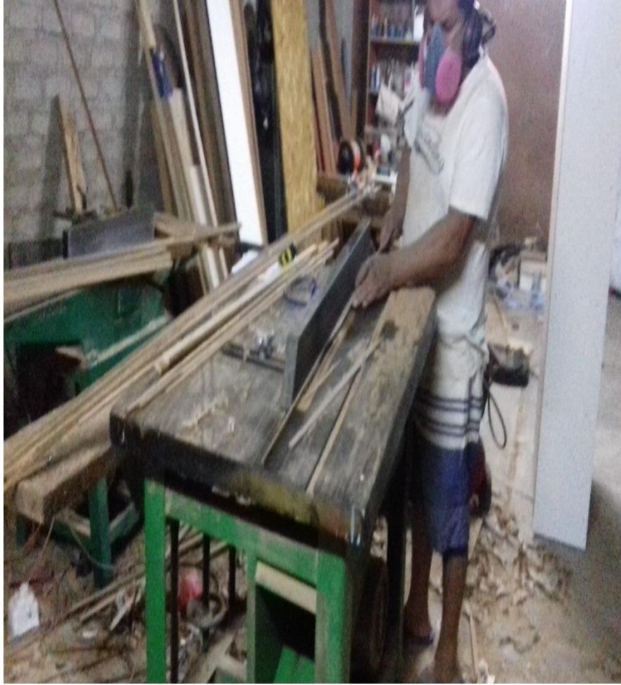
Figura N°1 Se muestra la habilitación de la madera para estructuras y encofrados
