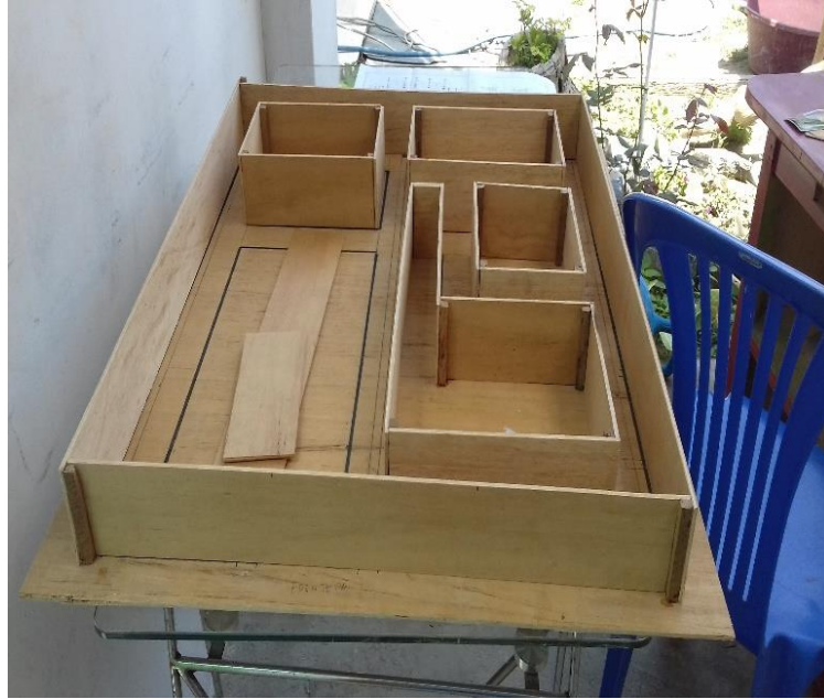
Figura N°3 Se muestra como se realizó el encofrado de la cimentación
