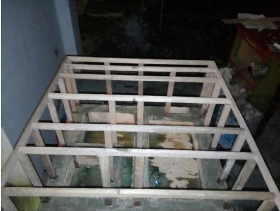
Figura N°10 Se dejó que el concreto fraguara por unos 3 días, luego se procedió al desencofrado
