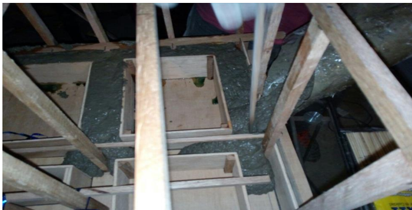
Figura N°9 Se realizó el vaciado del concreto en los moldes de madera
