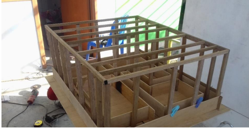
Figura N°7 Se colocaron las vigas
