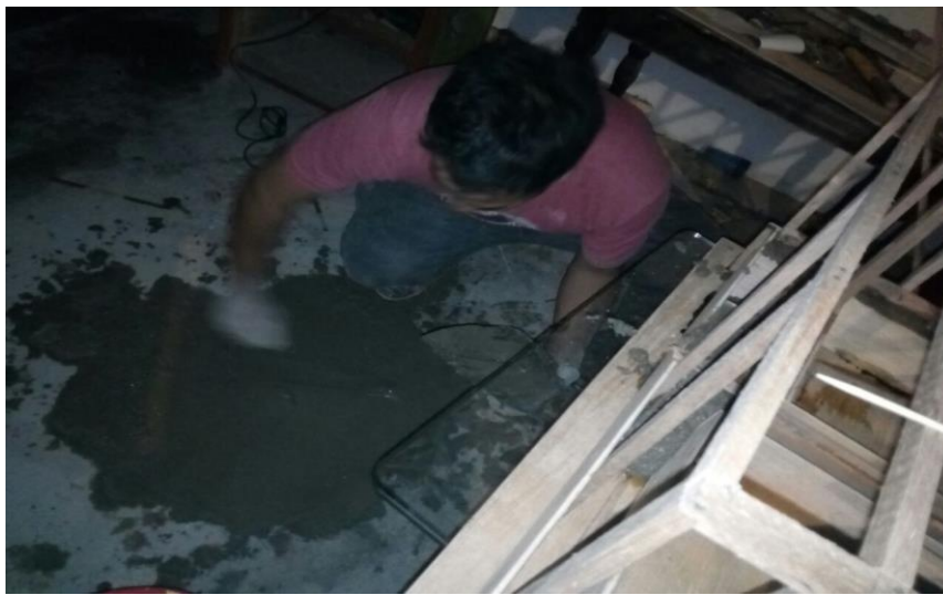
Figura N°8 Se realizó el concreto de forma manual
