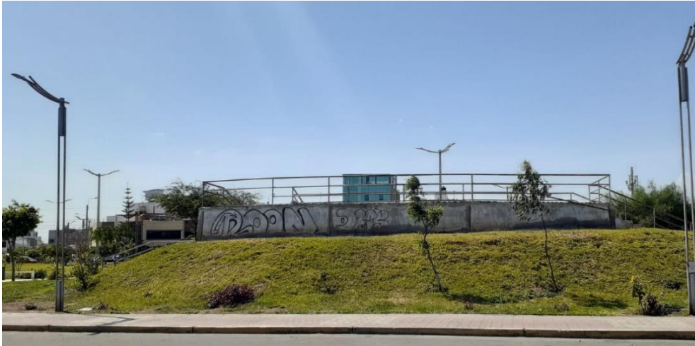
Leyenda: Falta de mantenimiento del área del Mirador del Parque Mártires de la Fe, foto tomada en mayo 2023.
