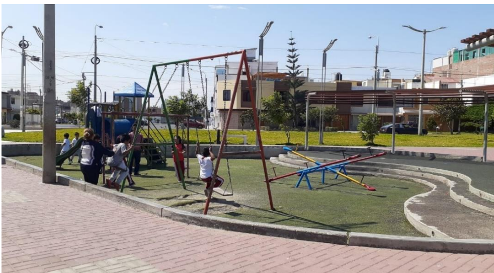
Leyenda: Área de Juegos Infantiles en estado de deterioro del Parque Mártires de la Fe, foto tomada en mayo 2023.
