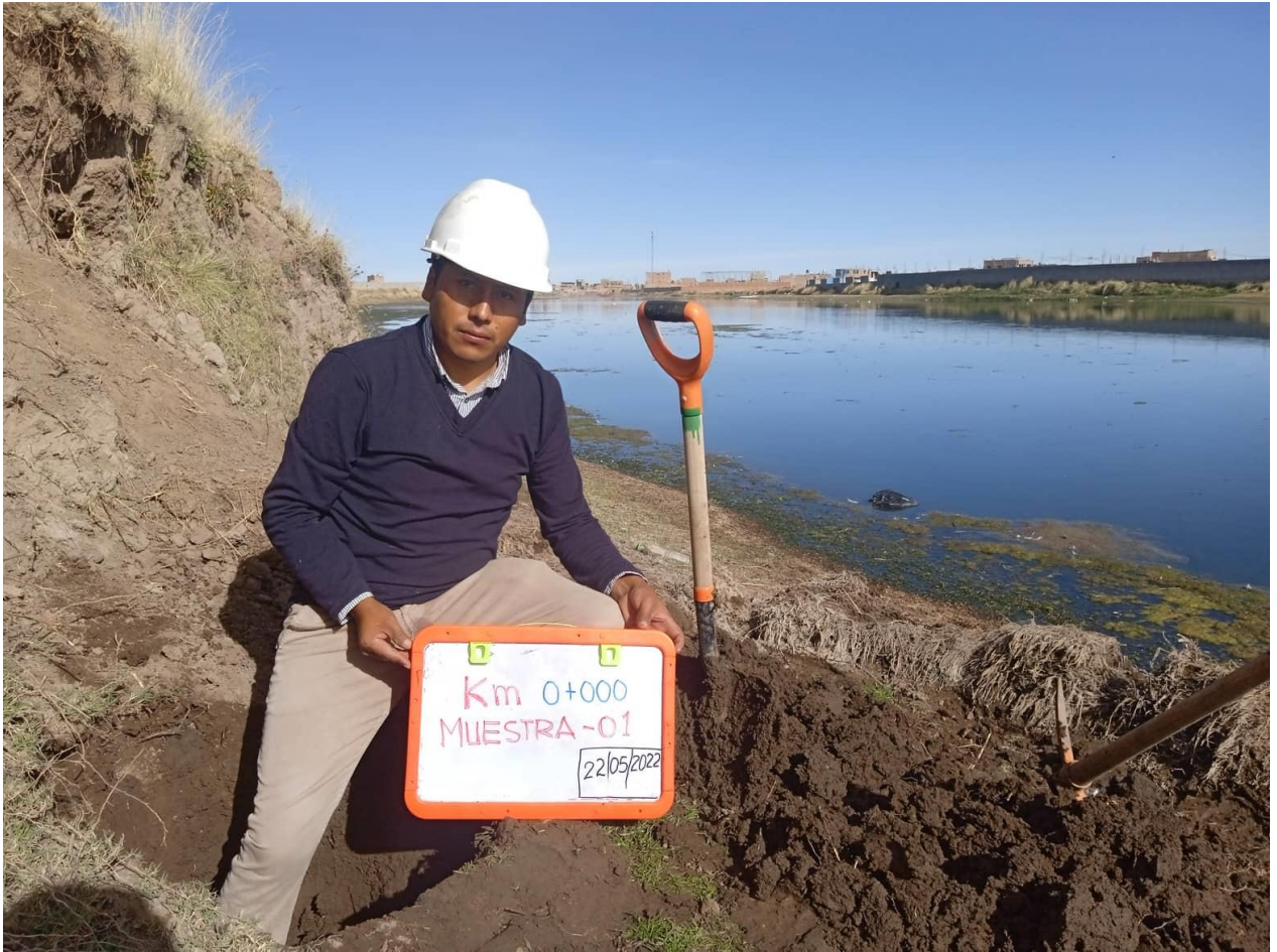
Figura 23: Excavación caliacata N° 1; progresiva Km. 0+000
