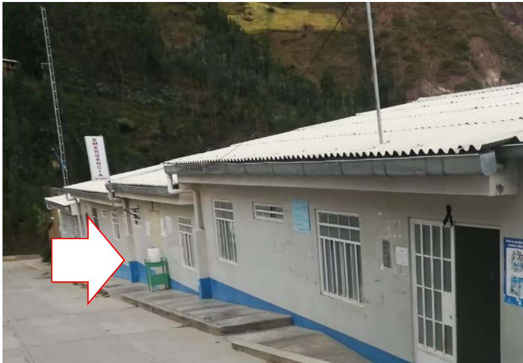
Ingreso a la UPSS de emergencia.
