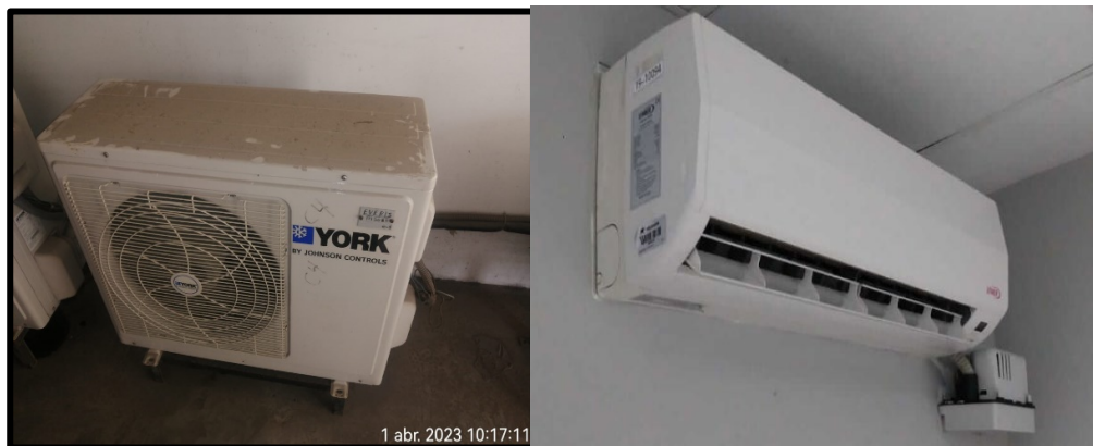
Figura 5. Partes de un sistema aire acondicionado Split para pared Origen: Empresa Frigosfer SAC
