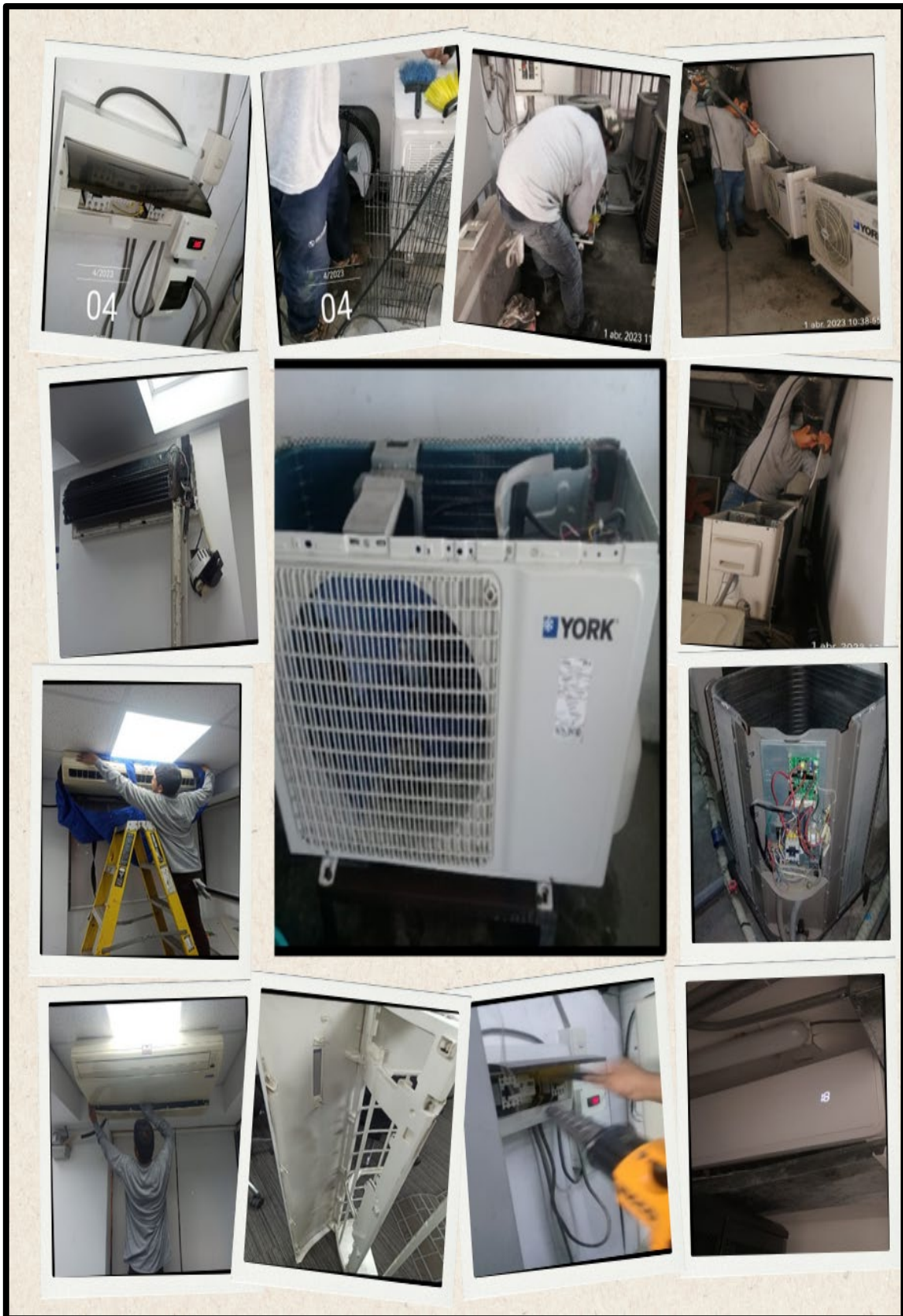
Figura 6. Mantenimiento de un equipo de refrigeración de FRIGOSFER SAC Origen: Los investigadores
