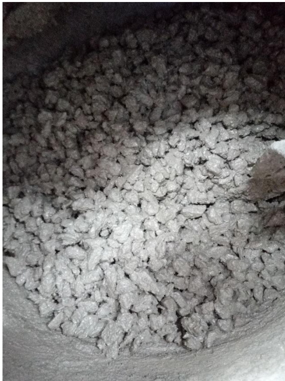
Imagen N° 2: Elaboración de concreto permeable en mezcladora tipo trompo.
