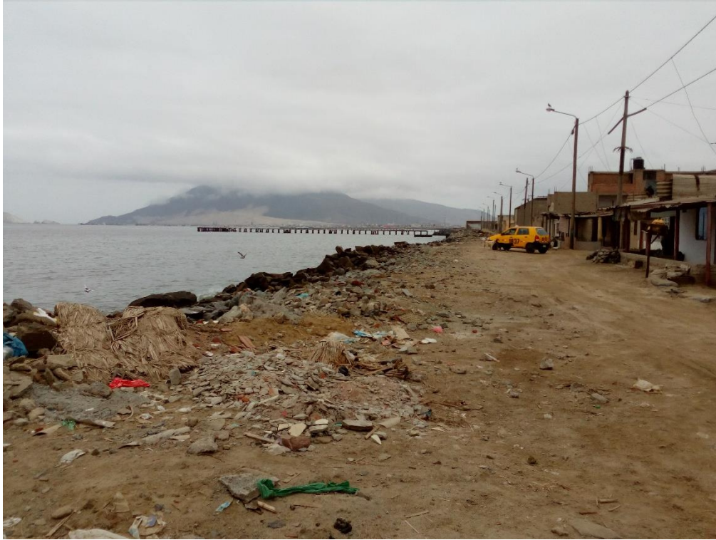
Imagen N° 9: Vista de la prolongación Malecón Grau en el Pueblo Joven Florida Baja.
