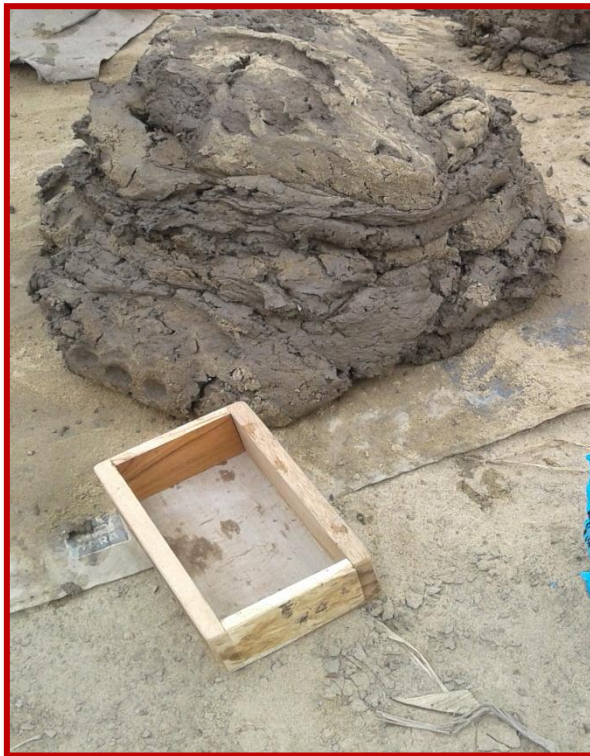
Fotografía 04: Gavera utilizada para la fabricación de los ladrillos
