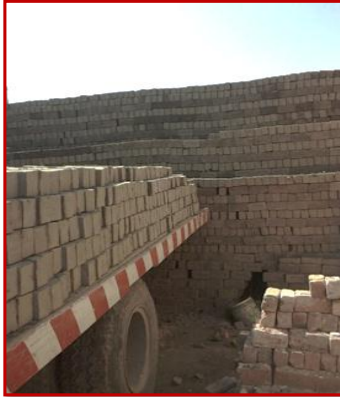
Fotografía 11: Acomodo y llenado de los ladrillos al horno
