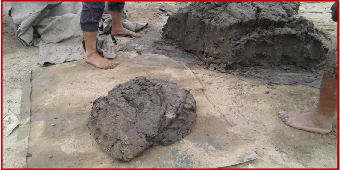
Fotografía 01: Mezcla en reposo, luego de haber sido preparada.
