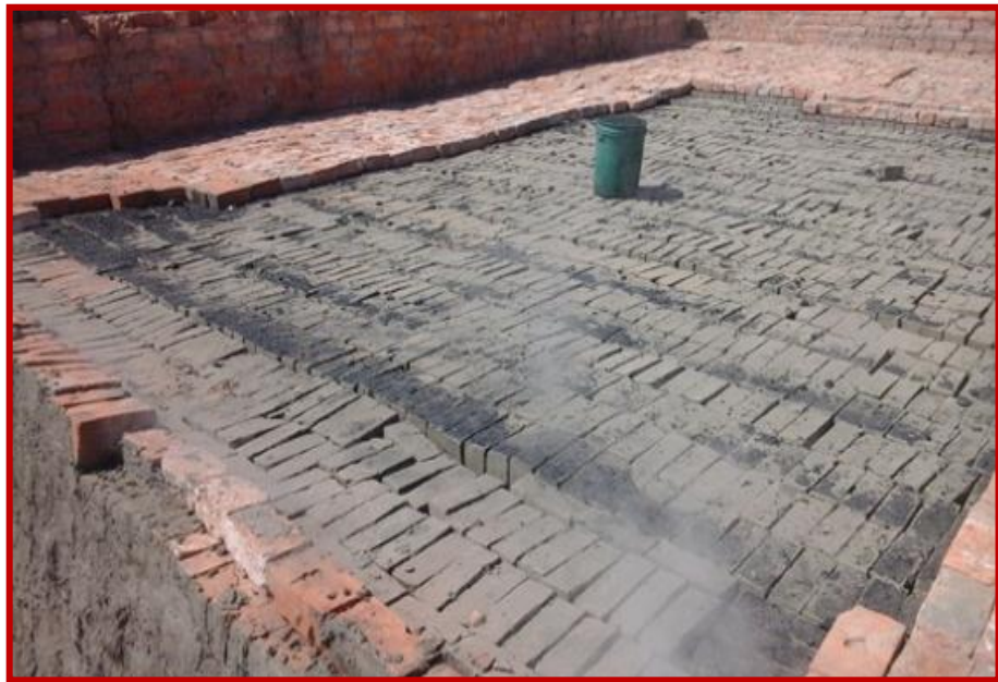
Fotografía 12: Inicio del proceso de quemado de los ladrillos en el horno
