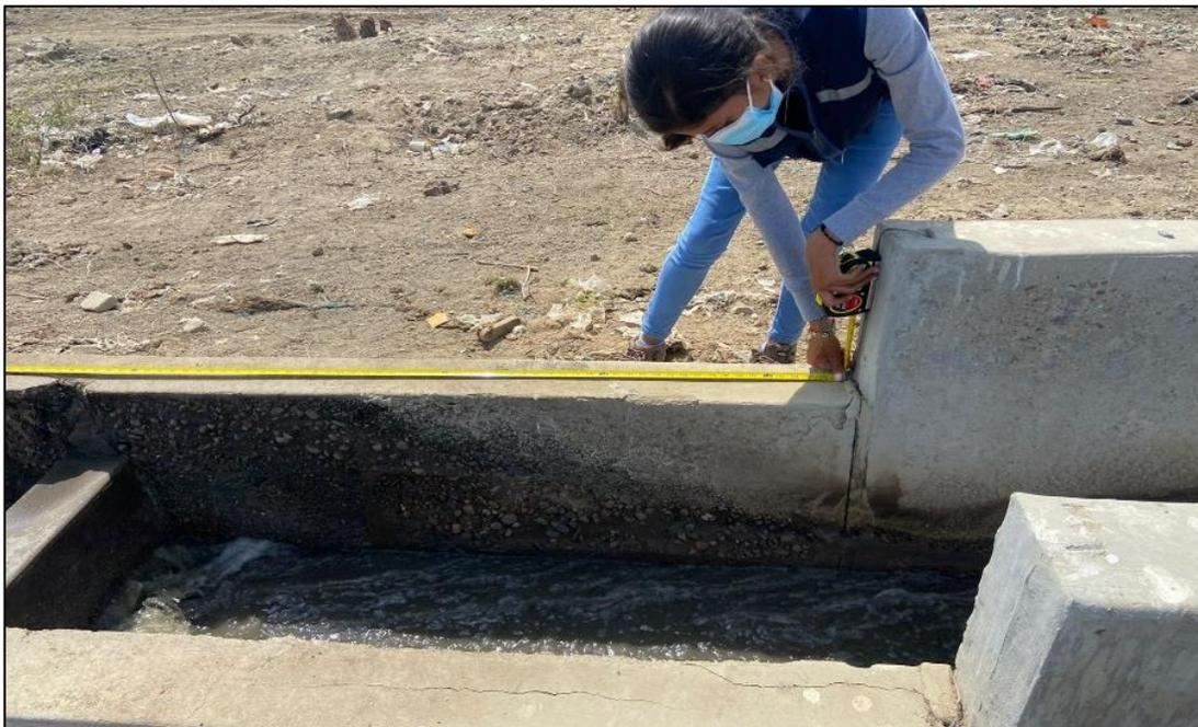
**Figura N° 06.** *Identificación de patologías en el medidor Parshall.*
