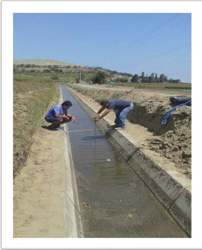
Foto N° 5: vista del seccionamiento del canal
