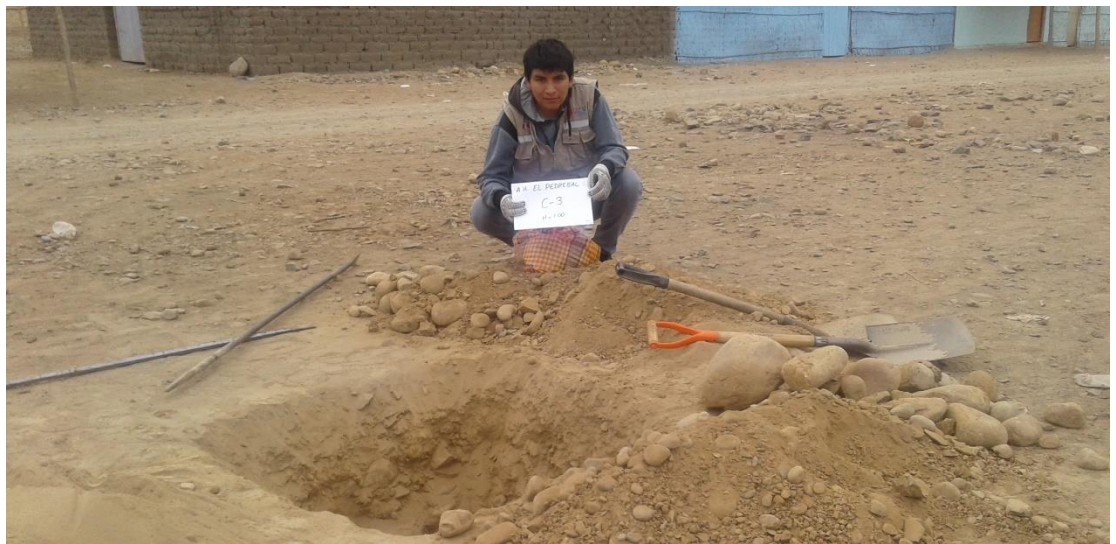
Ilustración 10: Realización de los estudios de mecánica de suelos en el Asentamiento Humano el Pedregal.
