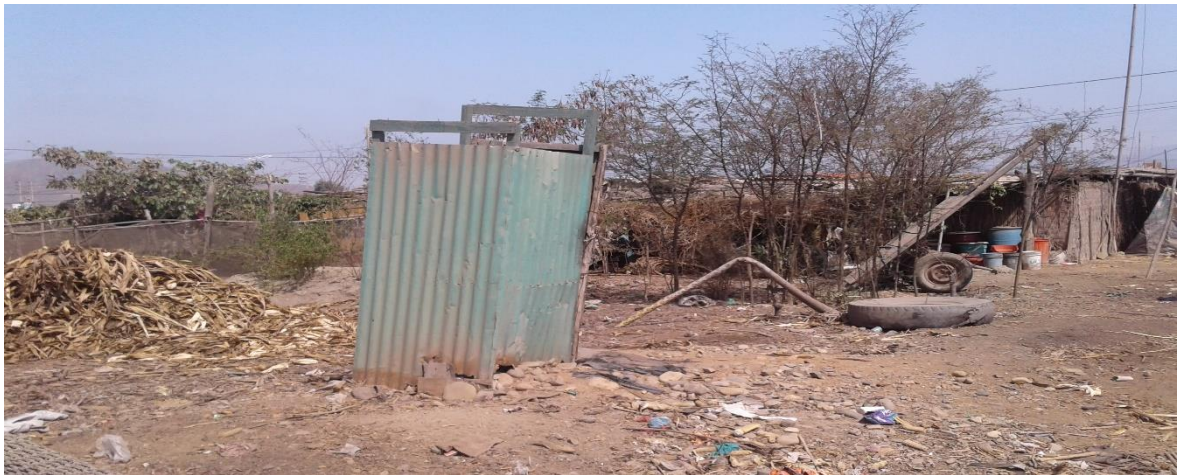
Ilustración 5. Se observa que la letrina se encuentra en un deterioro por no darle ningún mantenimiento.
