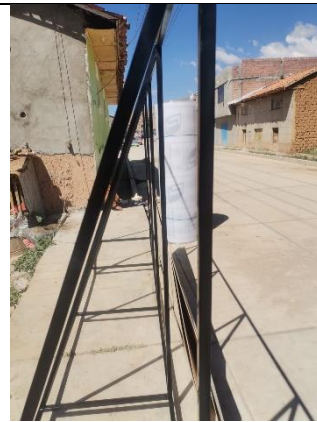
Foto 10: Armazón metálico armado y pintado.
