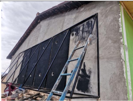
Foto 11: Pintado de muro tarrajeado.
