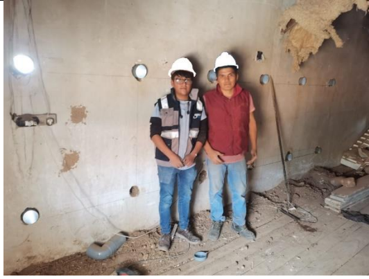
Foto 07: Posterior al colocado de tubos de PVC 4”.
