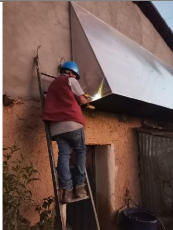
Foto 13: Instalación de cobertura de policarbonato.
