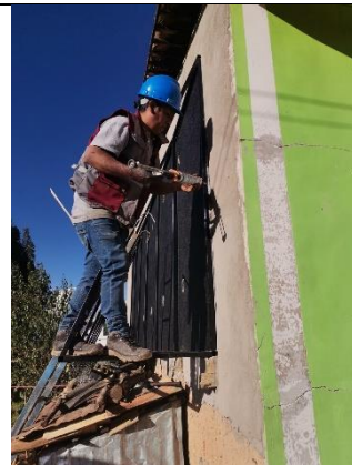
Foto 12: Sellado de bordes de armazón con silicona.
