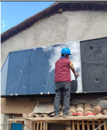
Foto 15: Instalación de cobertura de vidrio.
