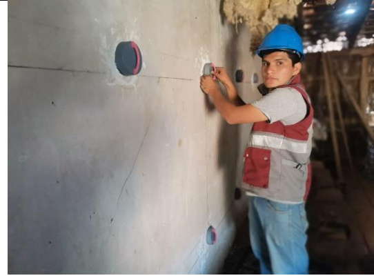
Foto 08: Colocado de tapas PVC 4”.
