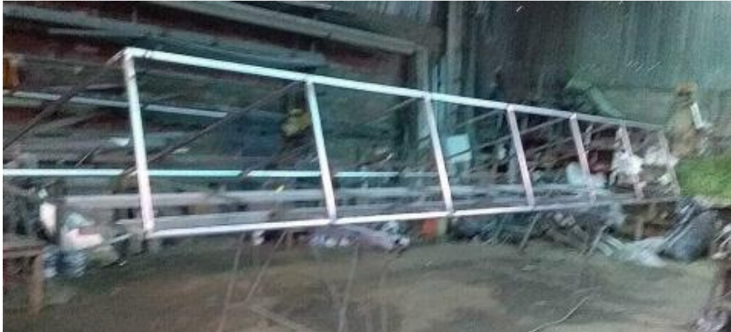
Figura 21: Construcción de la estructura del muro trombe en cerrajería.
