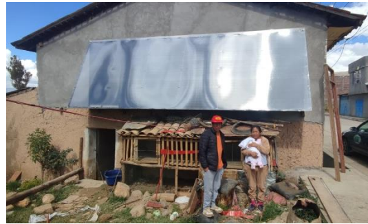
Foto 14: Muro trombe con cobertura de policarbonato terminado.
