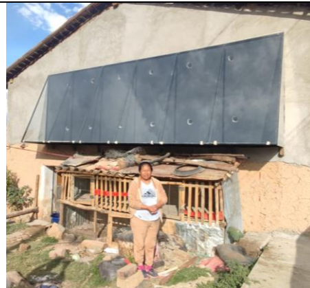
Foto 16: Muro trombe con cobertura de vidrio terminado.
