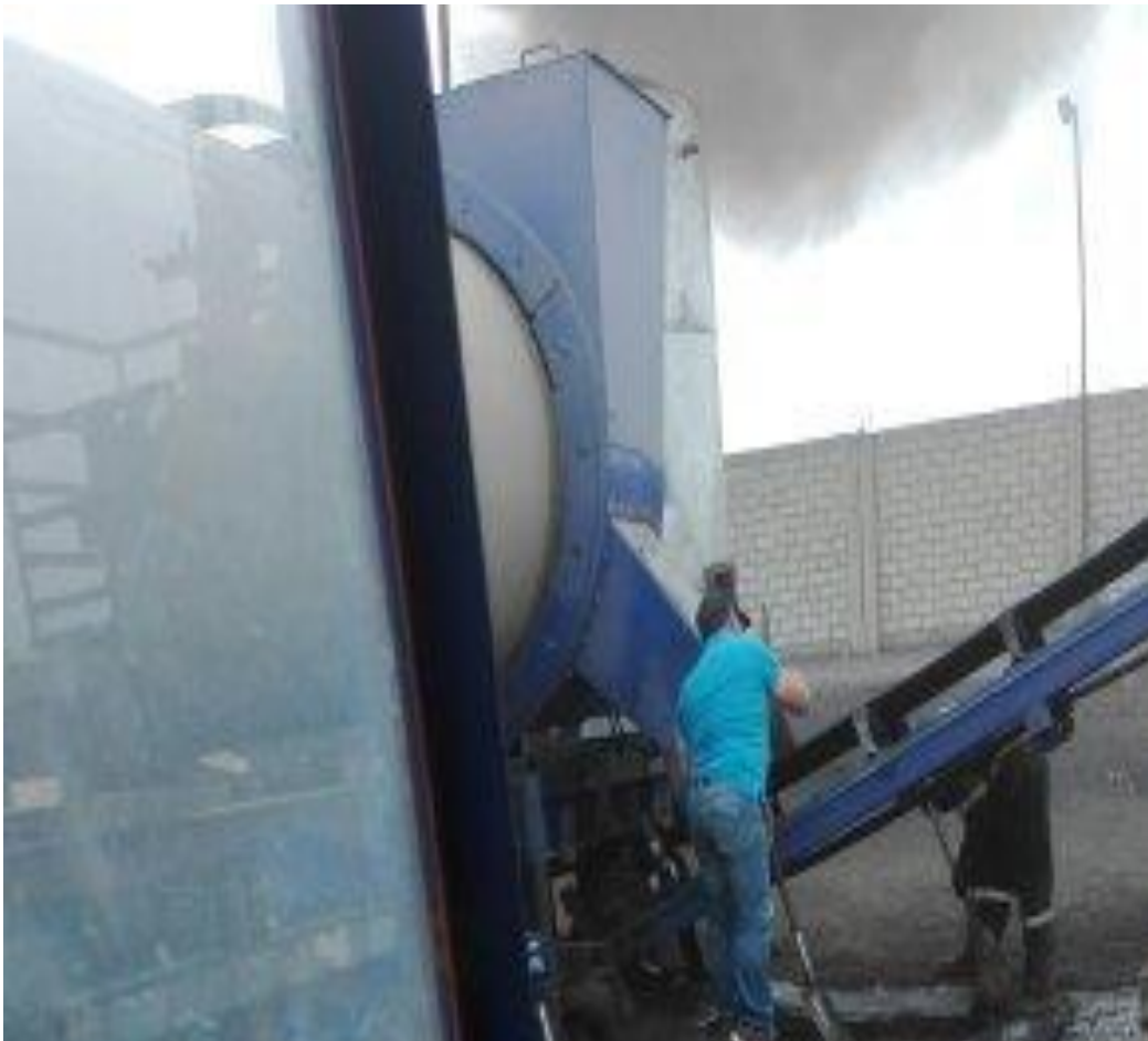
Figura 9. Parker plant sin filtro
