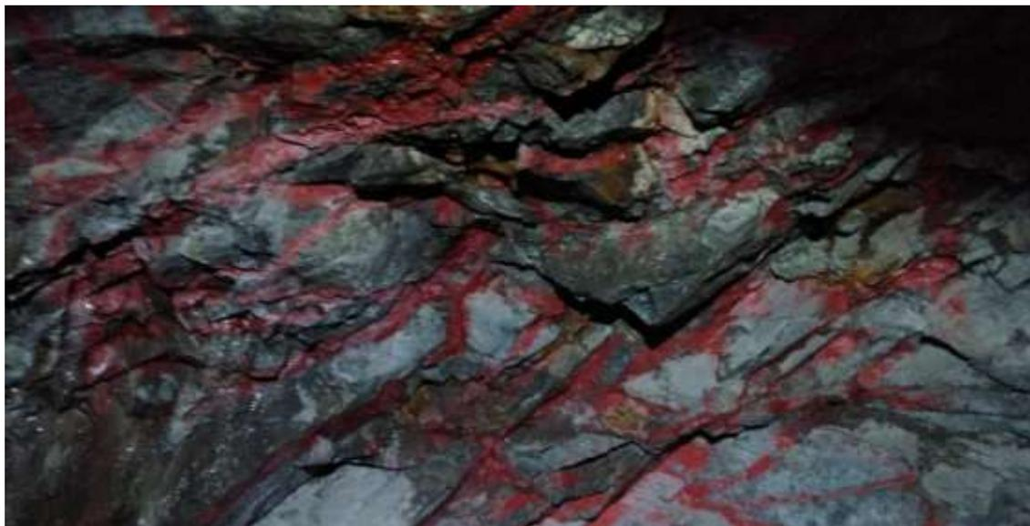
**Figura 2.** Presencia de fracturas en el contorno de la galería NE 01.
