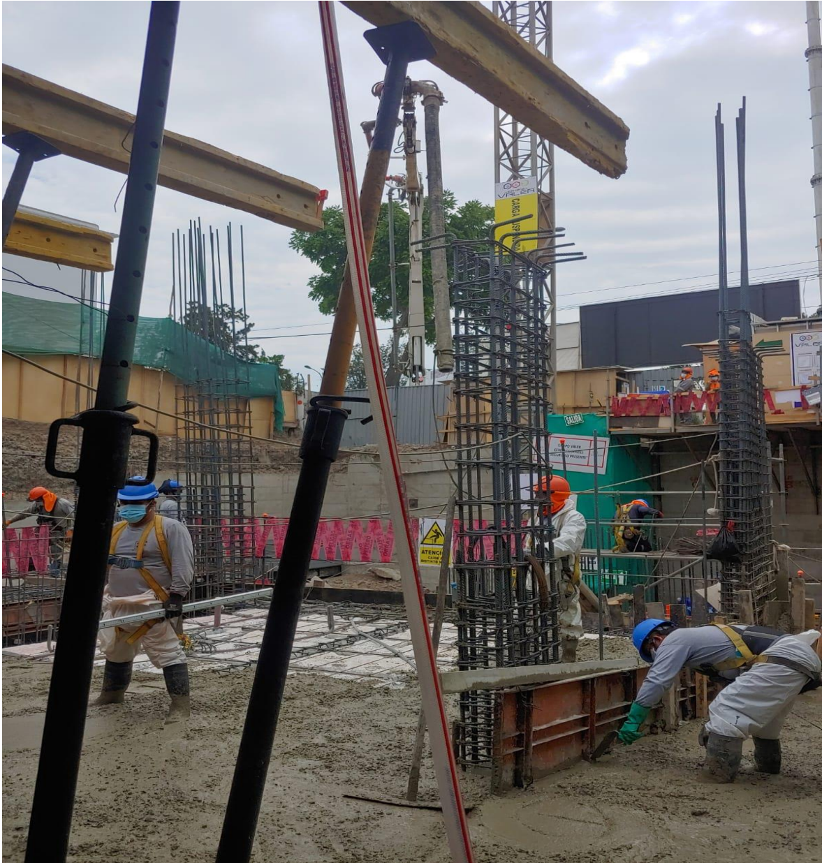
Figura N° 8: Colocación del concreto en la prelosa.
