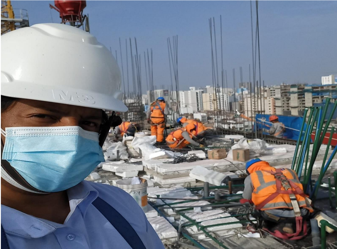
Figura N° 7: Instalaciones de Eléctricas y Sanitarias
