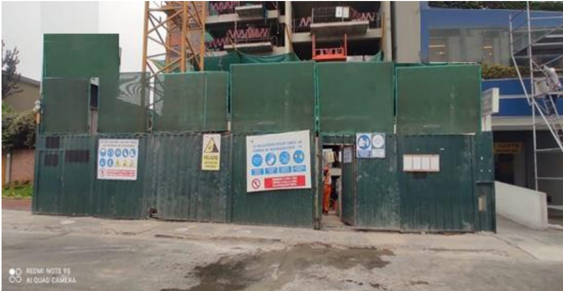
Figura N° 1: Vista frontal de la Obra en ejecución
