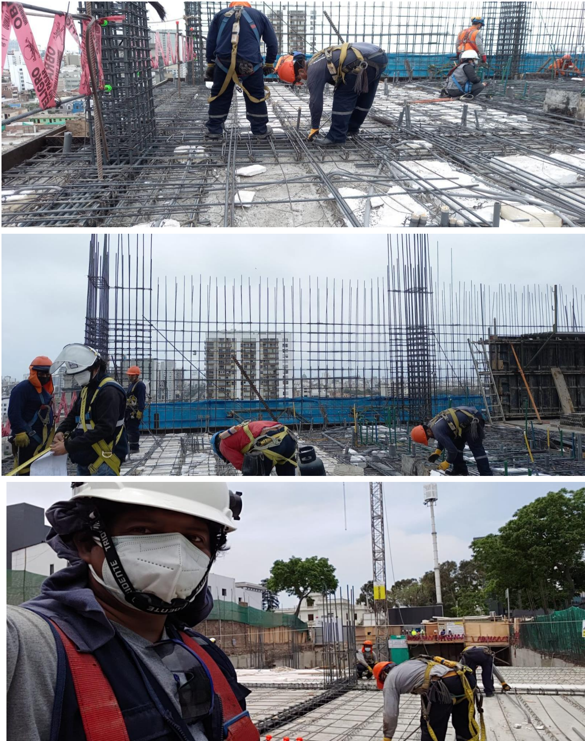
Figura N° 6: Habilitación y colocación del acero en vigas y losa
