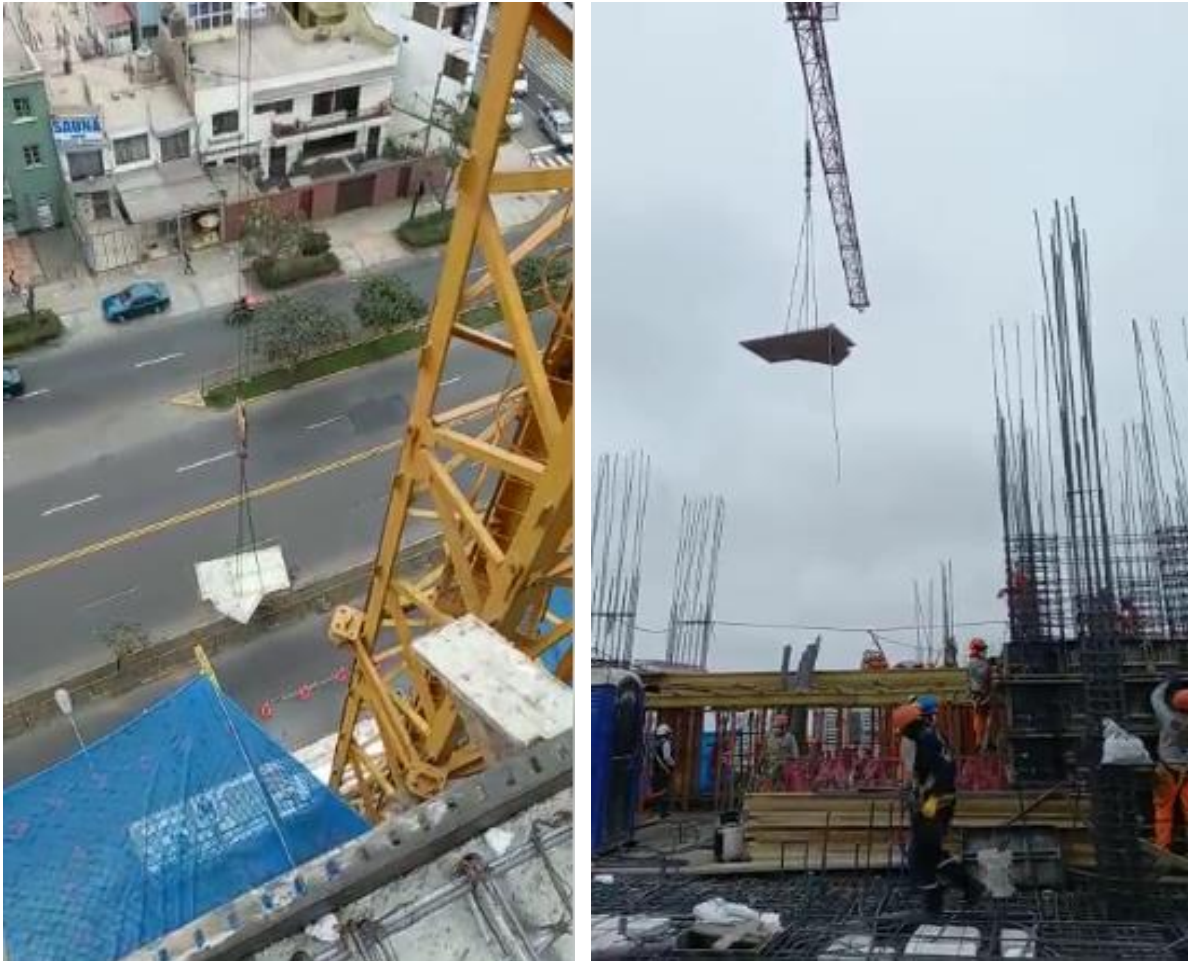
Figura N° 4: Izaje de la prelosa.
