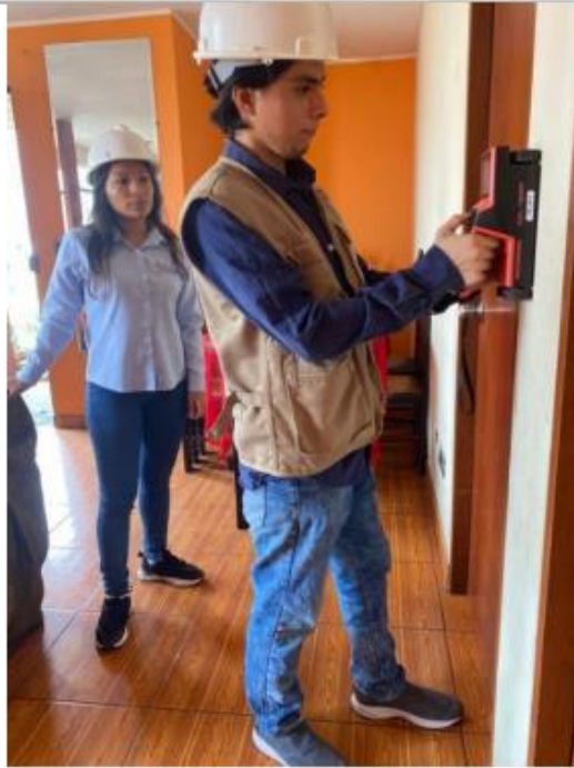
Imagen 3 – Toma de datos [Escáner de acero en Columna].
