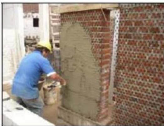
Figura 8. Muro reforzado con mallas polímeros
