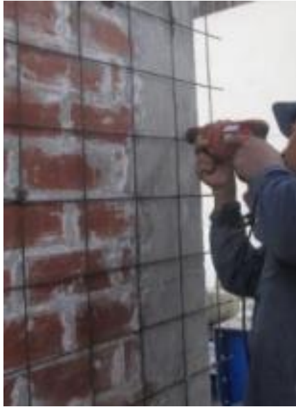
Figura 2. Instalación de malla electrosoldada en muro,
