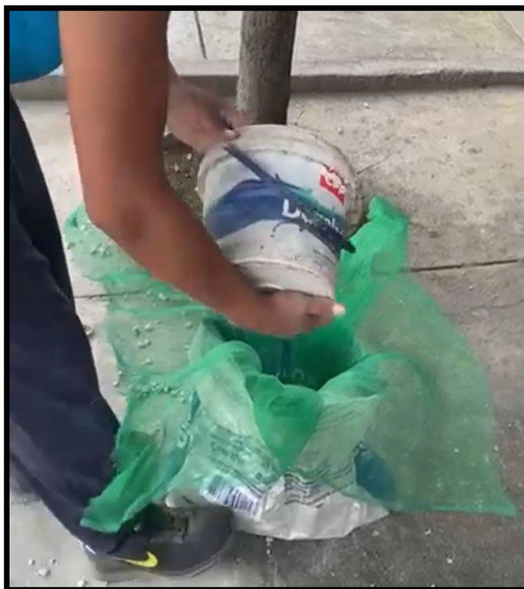
Figura 18. Escombros pasando la malla fina.
