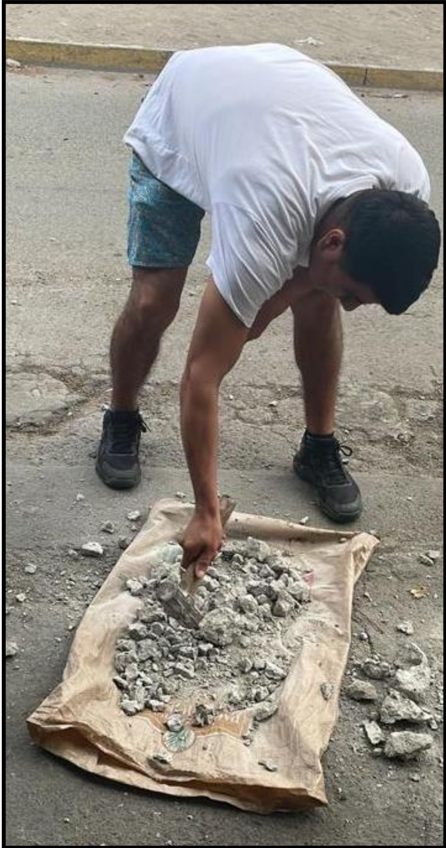
Figura 16. Segundo día de Trituración manual a los escombros.
