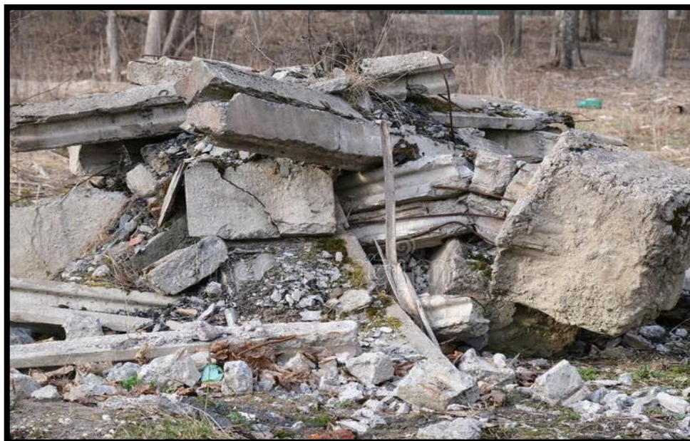
Figura 9. Escombros de construcción.
