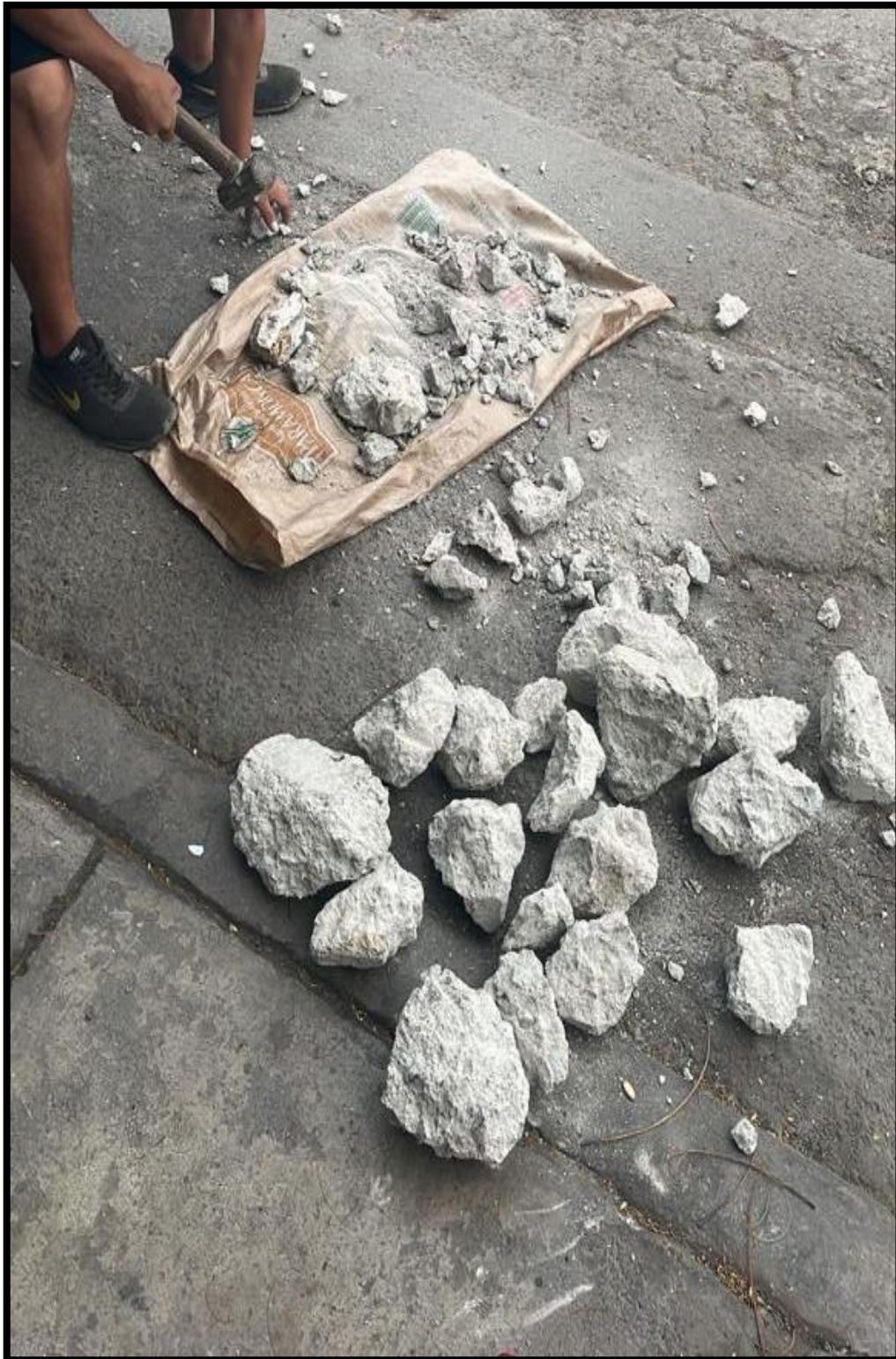
Figura 14. Primer día de Trituración manual con comba a los escombros.
