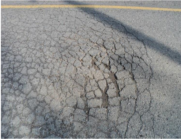
Figura 4 Agrietamientos del pavimento / Desprendimiento del pavimento Av. Universitaria, Fuente Propia (12/04/2023 01:24 pm)
