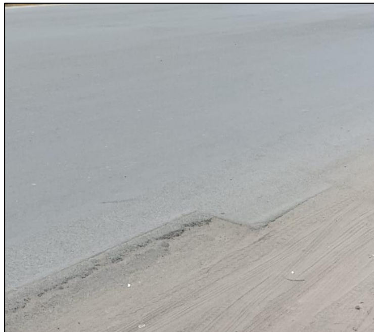
Figura 29, Desprendimiento en borde, Fuente: Propia.
