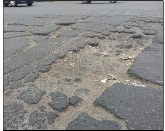
Figura 4 Agrietamientos del pavimento / Desprendimiento del pavimento Av. Universitaria, Fuente Propia (12/04/2023 01:24 pm)
