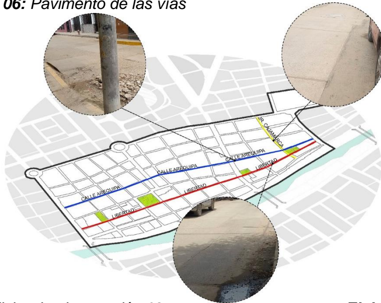
Figura N° 06: Pavimento de las vías
