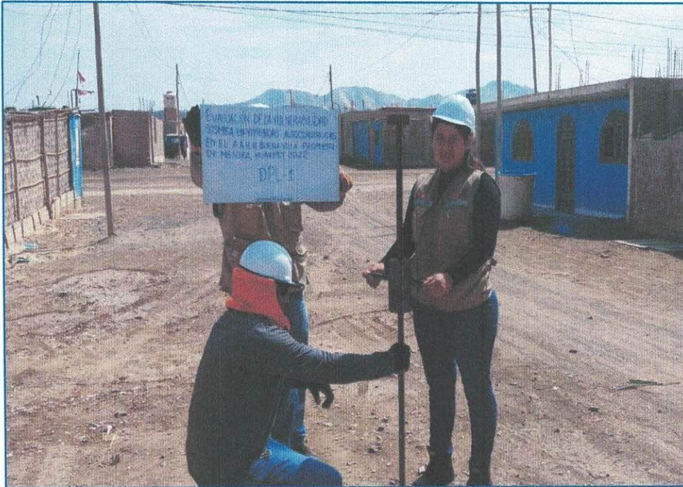
Imagen 03: se observa tecnicos realizando el ensayo DPL.
