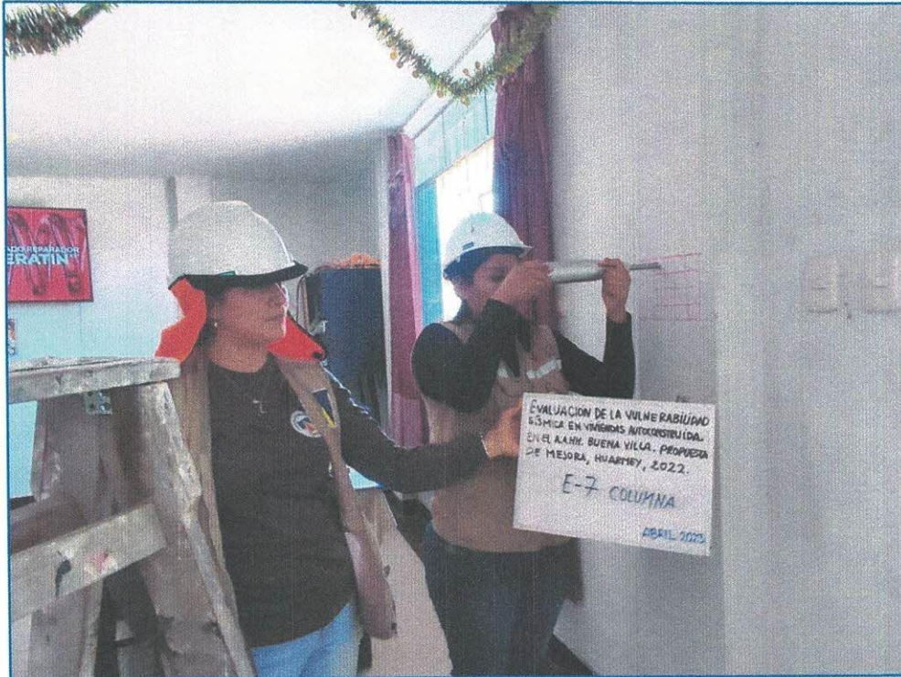
Imagen 11: Ensayo de Esclerometria en vivienda Mz D– Lt 01-AA.HH. Buena Villa, Huarmey.
