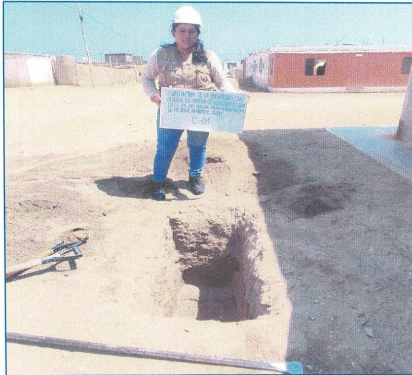
Imagen 29: se verifica la ubicación de la calicata C-01.
