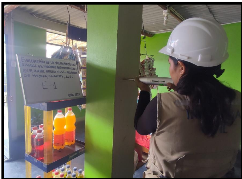
Fotografía 13. Ensayo de esclerometria en columna
