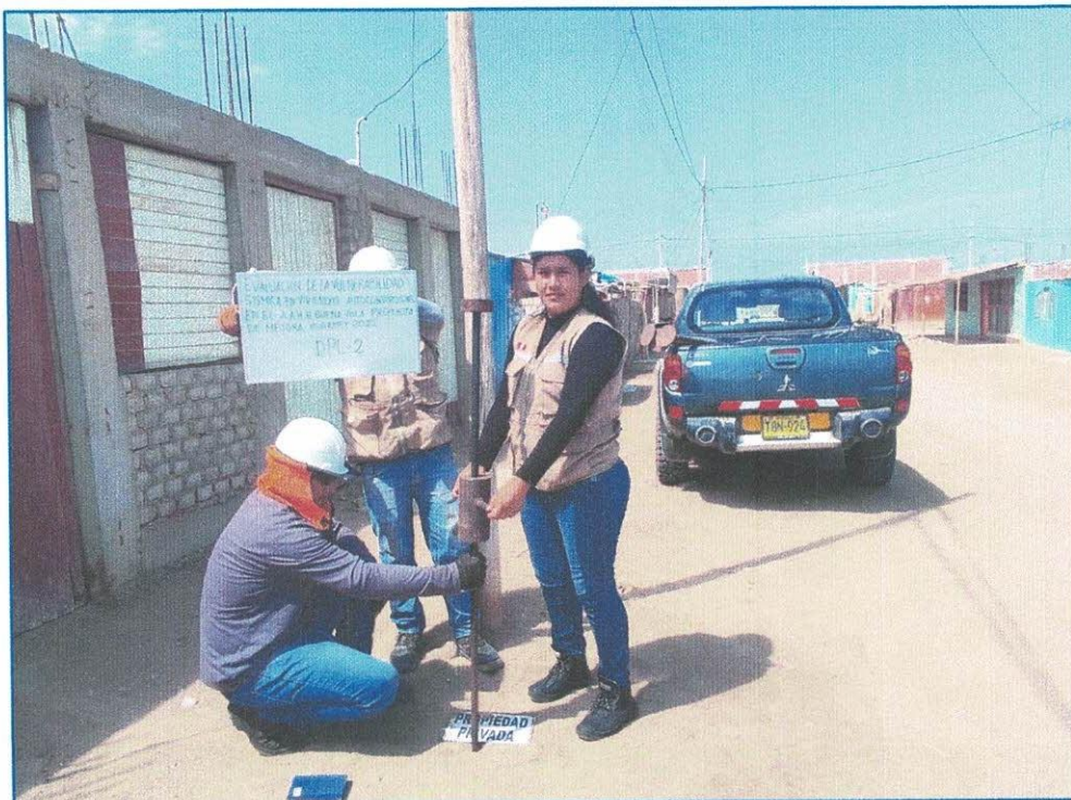
Imagen 04: se observa tecnicos realizando el ensayo DPL.
