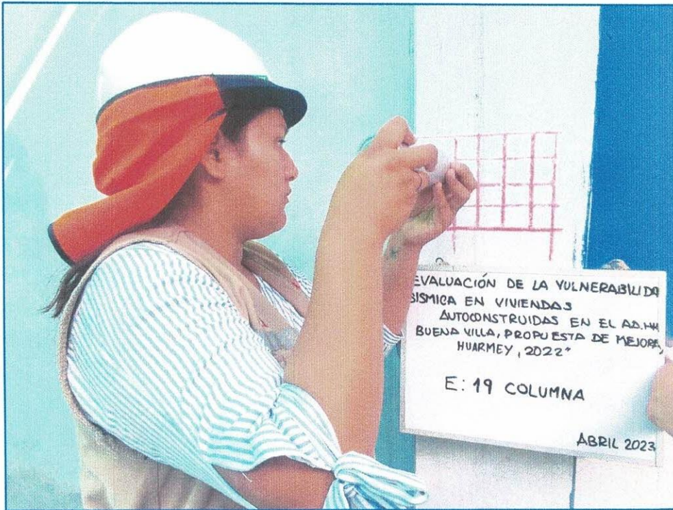
Imagen 23: Ensayo de Esclerometria en vivienda Mz M– Lt 11-AA.HH. Buena Villa, Huarney.
