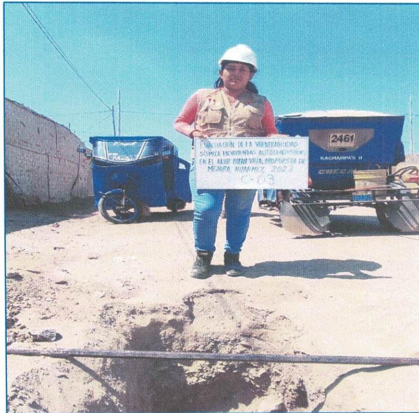
Imagen 31: se verifica la ubicación de la calicata C-03
