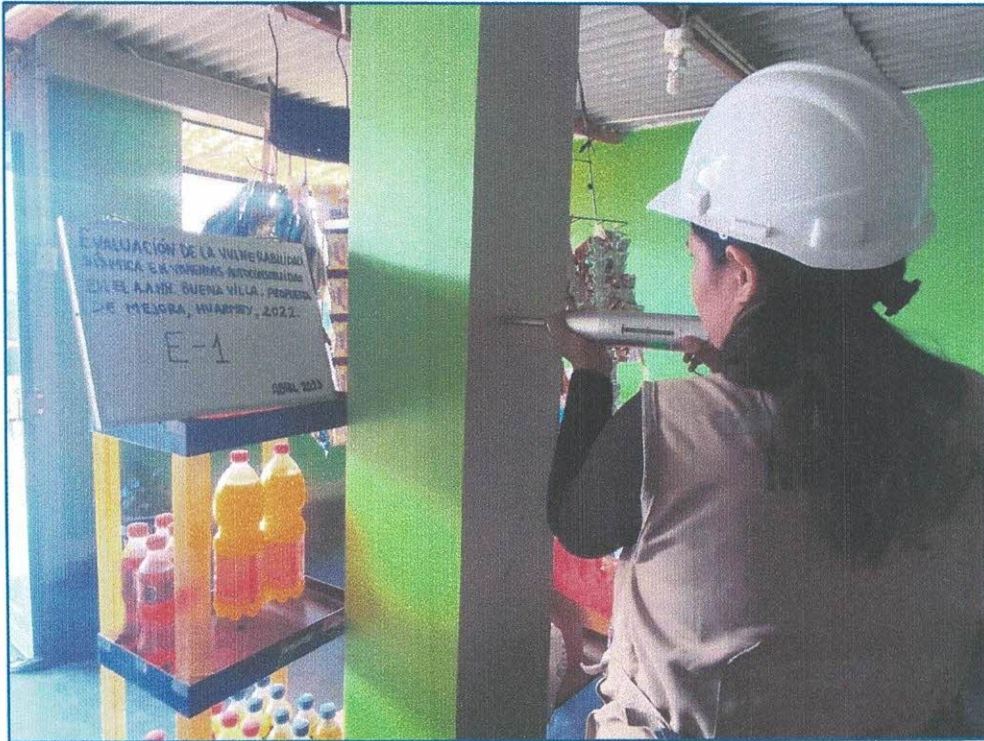
Imagen 05: Ensayo de Esclerometria en vivienda Mz P– Lt 13-AA.HH. Buena Villa, Huarmey.
