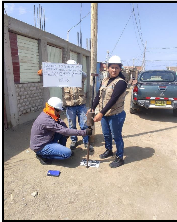
Fotografía 9. Realización de la auscultación DPL-02
