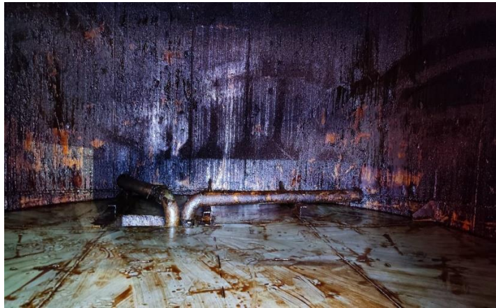
Vista de interna de tanque luego de limpieza.
