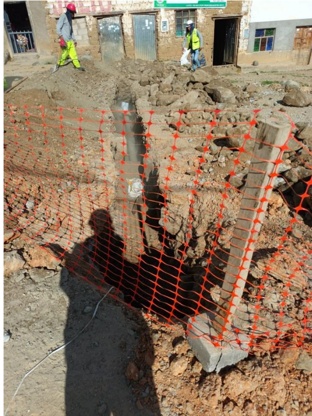
Fotografía 11: Uso de maallas de seguridad
