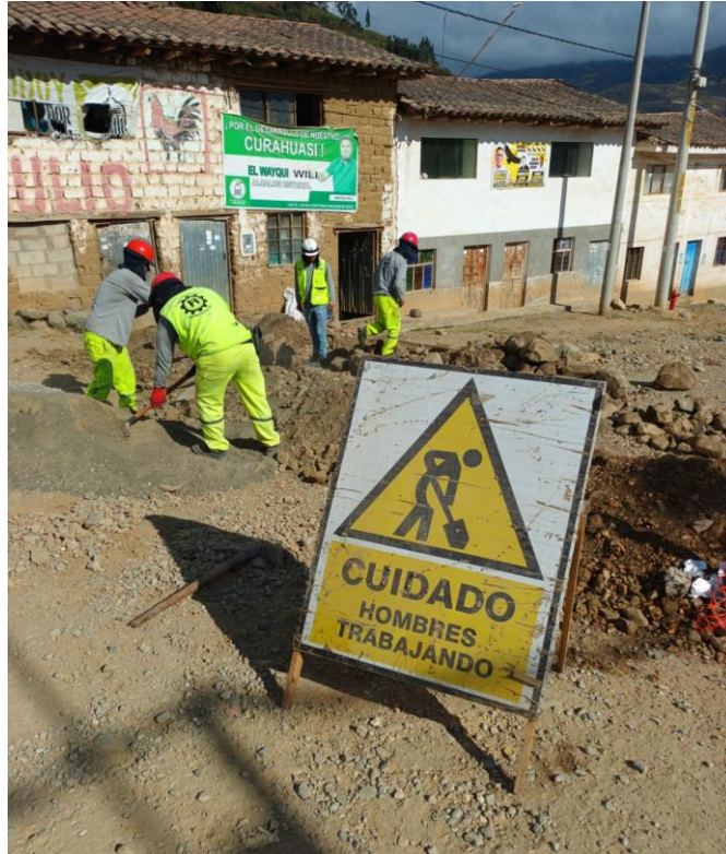
Fotografía 09: Uso de mallas y señalización de seguridad
