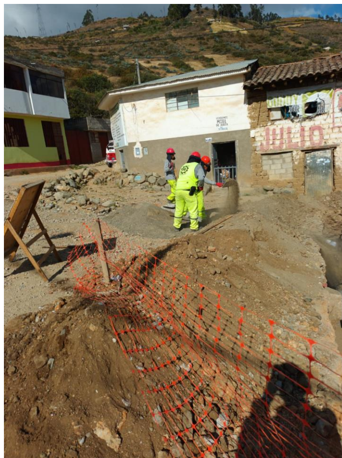
Fotografía 08: Uso de mallas y señalización de seguridad
