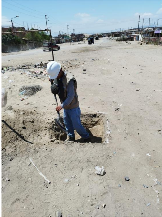
Figura 02: excavación de la calicata 1.50m
