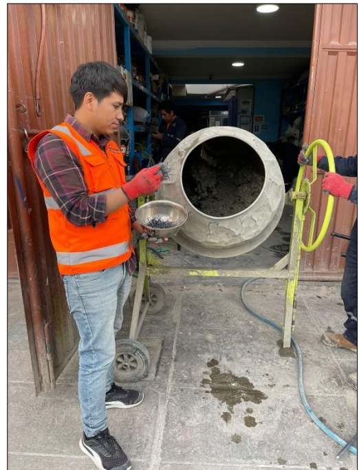
Figura N° 50: incorporación de acero en movimiento de Mezcladora, según diseño de mezcla (3% de fibras de acero).
