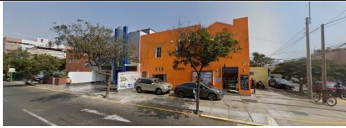
Se evidencian espacios públicos en un estado de conservación deficiente. Así mismo se evidencia espacios públicos con un correcto tratamiento de áreas verdes, pero con presencia de residuos sólidos.
