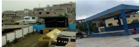
Se evidencia una infraestructura temporal ubicada en la calle William Cushing que colida I.E.I San Camilo y el anfiteatro del parque San Camilo, donde se dan conciertos de músicas y expresiones artísticas, durante fechas festiva, peor, sin embargo, no cuenta con la infraestructura adecuada.
