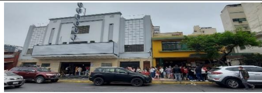
Se evidencian espacios públicos en un estado de conservación deficiente. Así mismo se evidencia espacios públicos con un correcto tratamiento de áreas verdes, pero con presencia de residuos sólidos.
