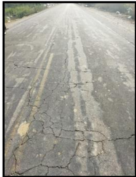
Foto N° 04. Toma fotográfica de la falla Tipo grietas longitudinales y transversales en el pavimento en estudio.
