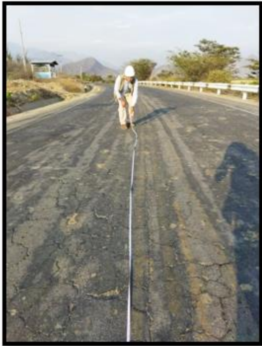
Foto N° 04. Toma fotográfica de la falla Tipo grietas longitudinales y transversales en el pavimento en estudio.
