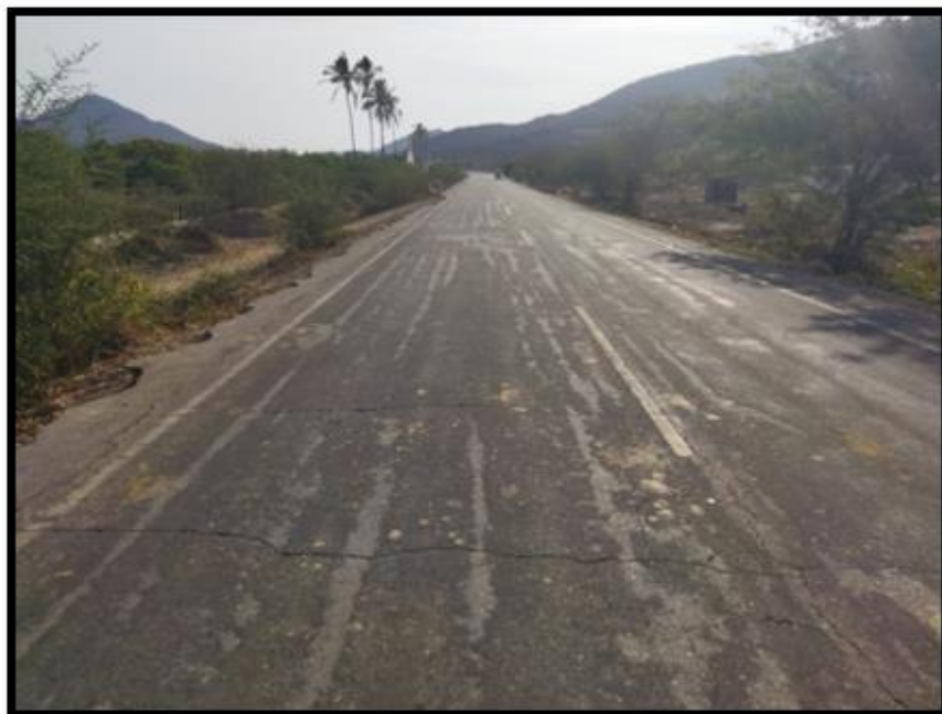
Foto N° 04. Toma fotográfica de la falla Tipo grietas longitudinales y transversales en el pavimento en estudio.
