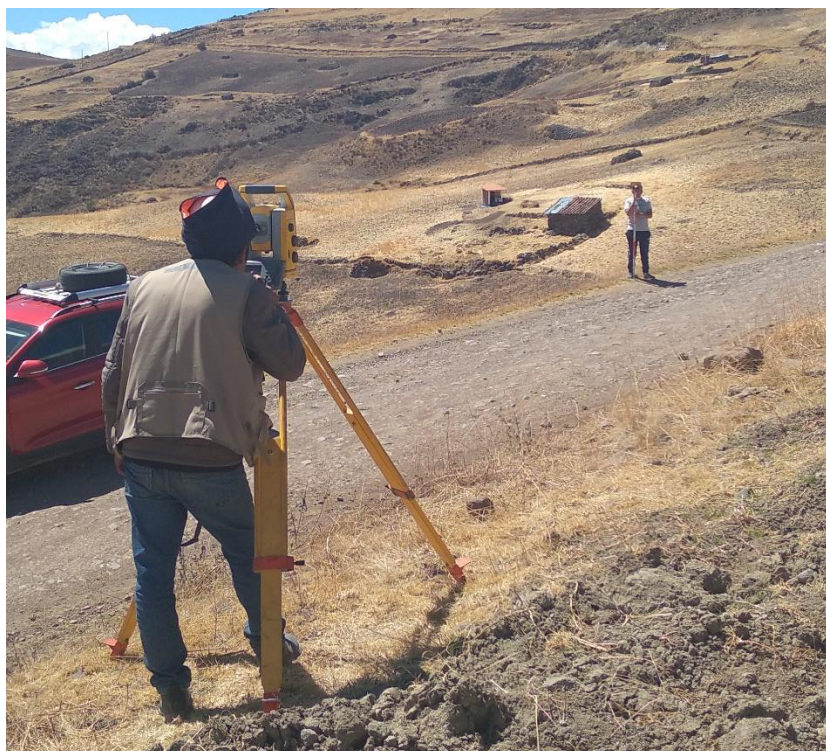
Figura 26. Levantamiento topográfico con estación total
