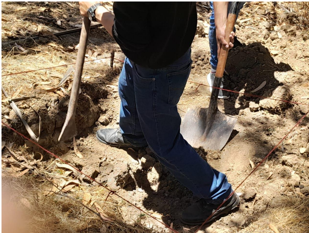
Figura 32. Excavación de Calicatas
