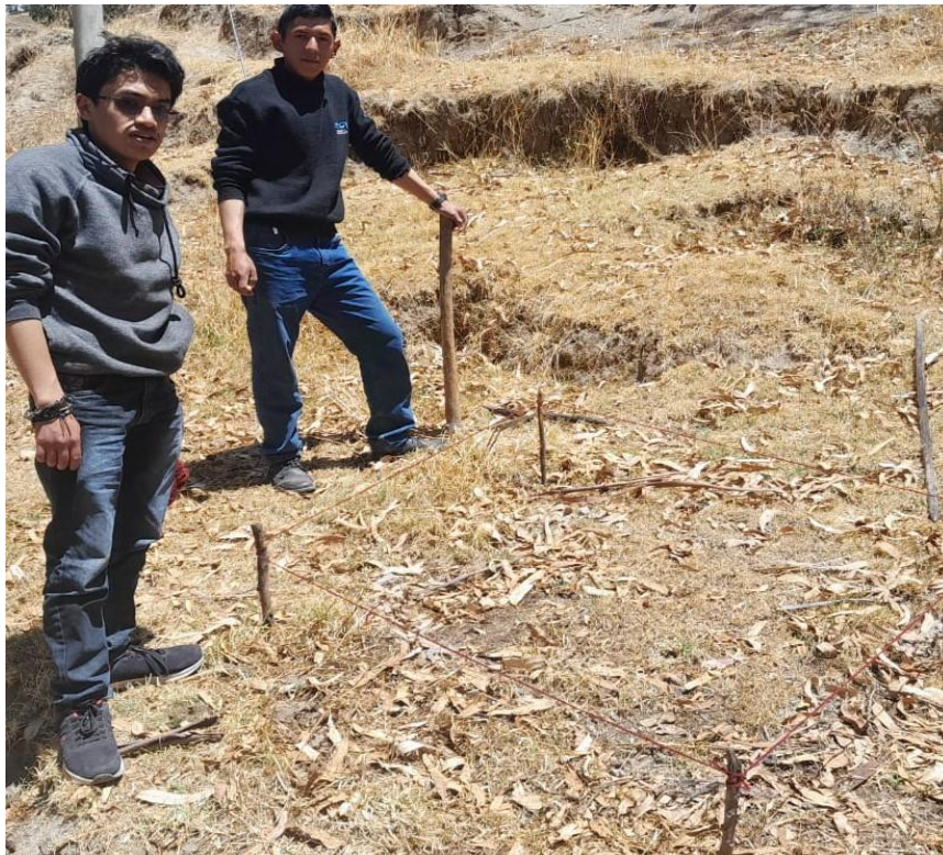
Figura 30. Marcación para excavación de calicata
