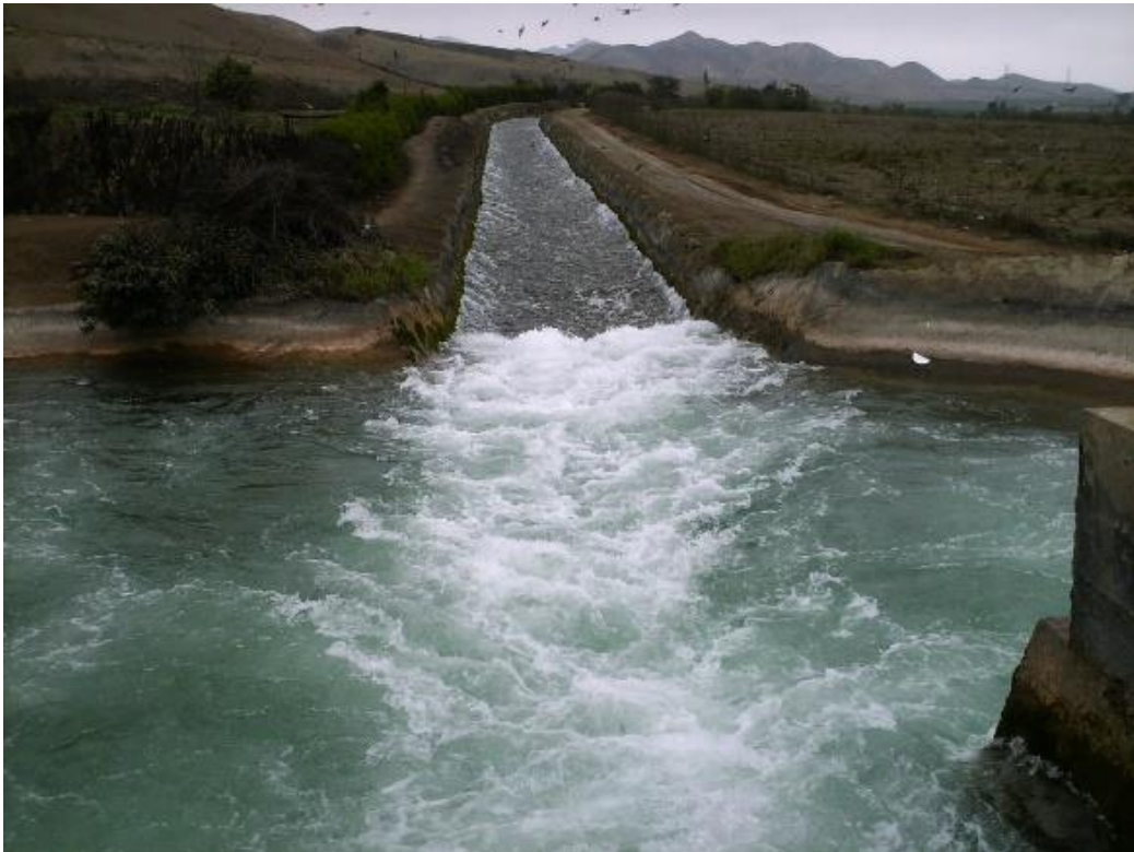
Figura 15: En las imágenes adjuntas se muestra el canal nuevo imperial, con un caudal aproximado de 8 m 3 /segundos.
