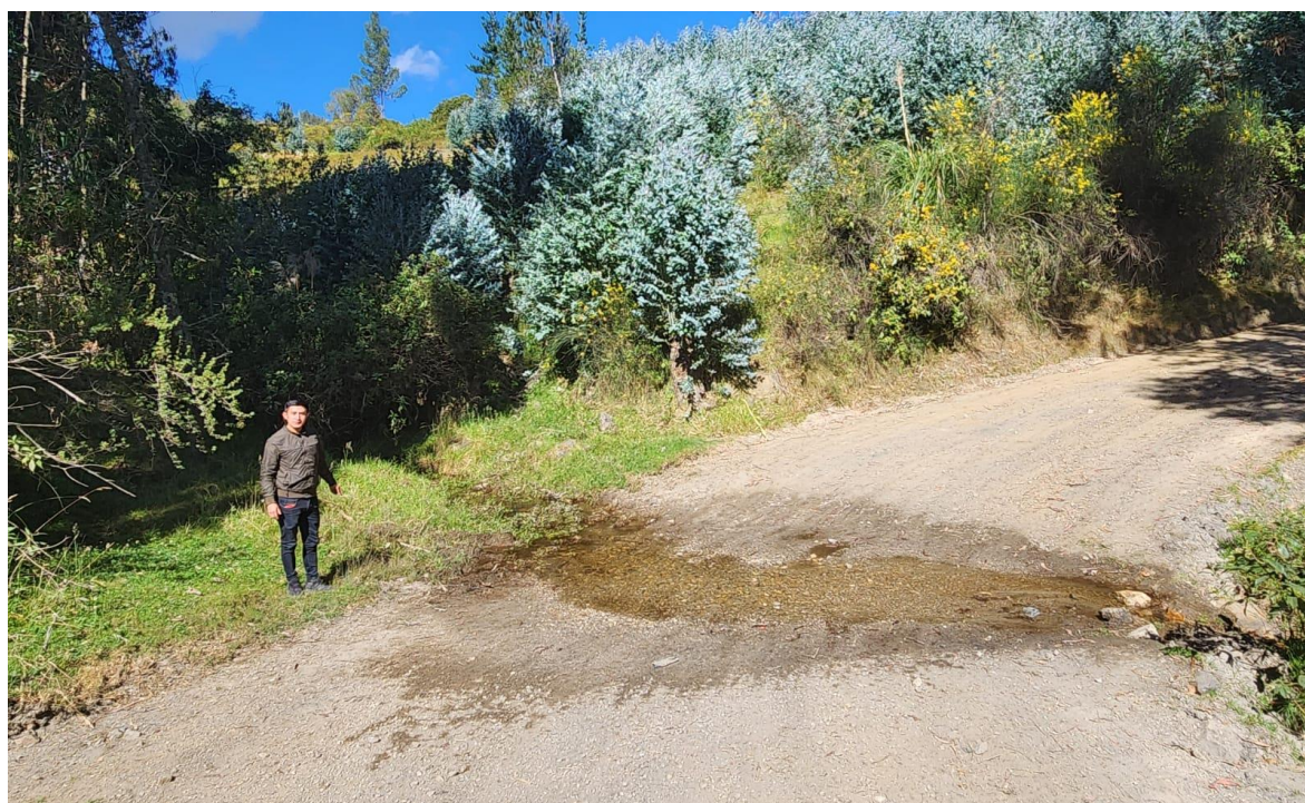
Fotografía 8: Observa la construcción de una alcantarilla de paso.
