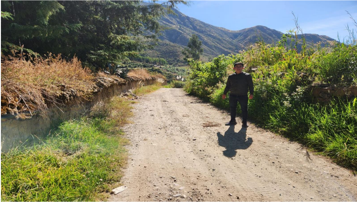
Fotografía 15: En la foto se aprecia que la vía no cuenta con una cuneta, esto sucede en toda la extensión del tramo, provocando que el agua cruce la vía.
