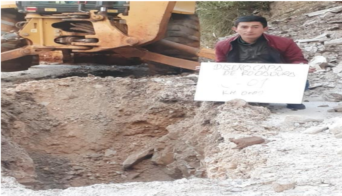
Fotografía 21: Se observa la excavación de la calicata 1, de donde también se extrajo material para el CBR1.
