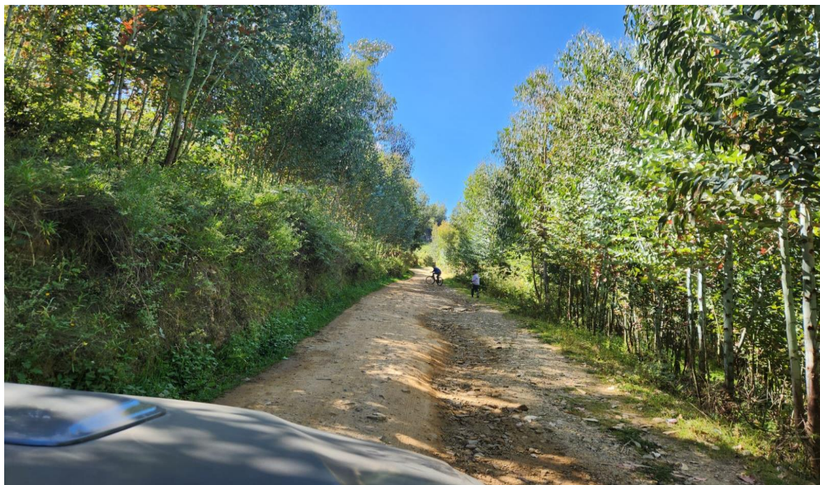
Fotografía 20: Se observa ahuellamiento en la vía y la falta de cunetas, provocando que el agua siga su curso en medio de la superficie de rodadura.
