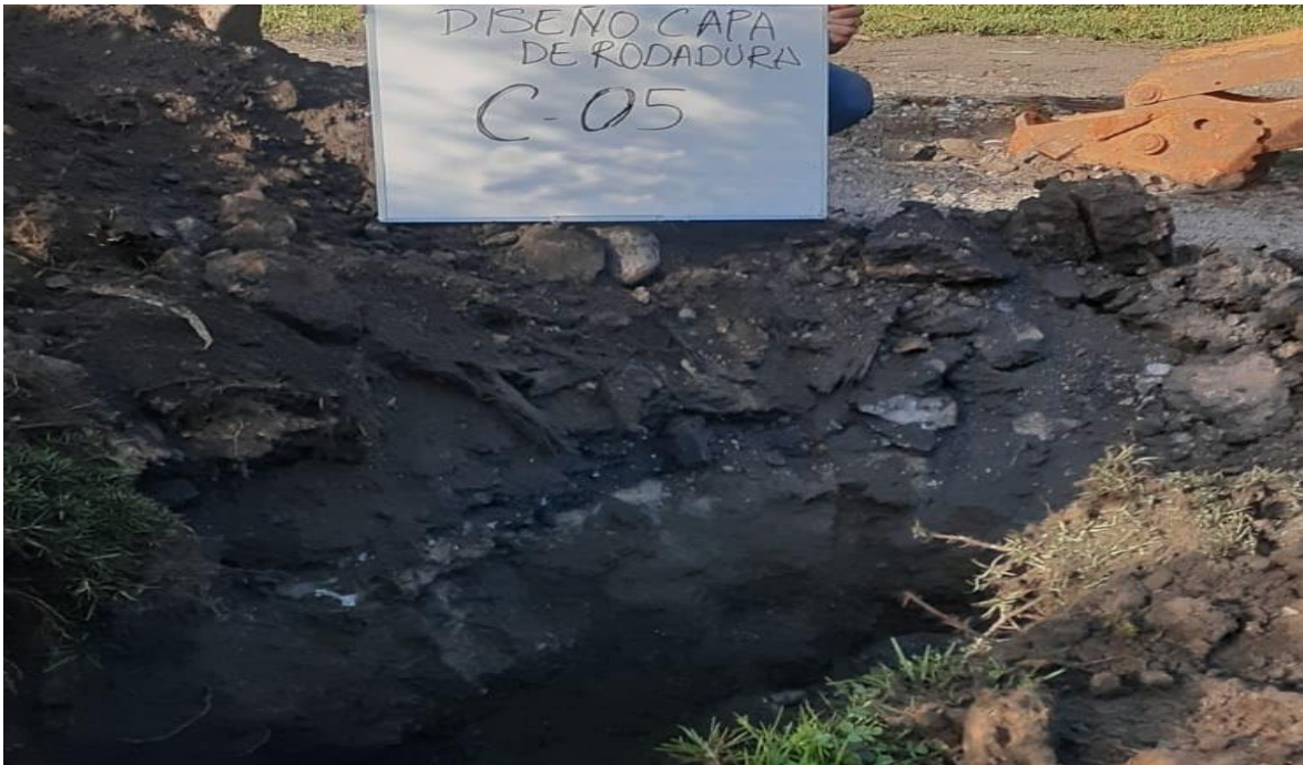
fotografía 26: Excavación de la calicata 5
