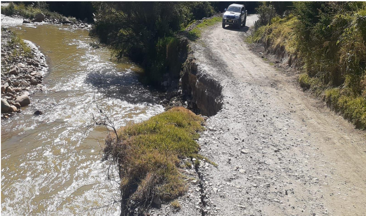
Fotografía 10: Al igual que en la primera imagen la plataforma de la carretera es muy angosta, este genera un peligro en seguridad la circulación de los vehículos por la vía.
