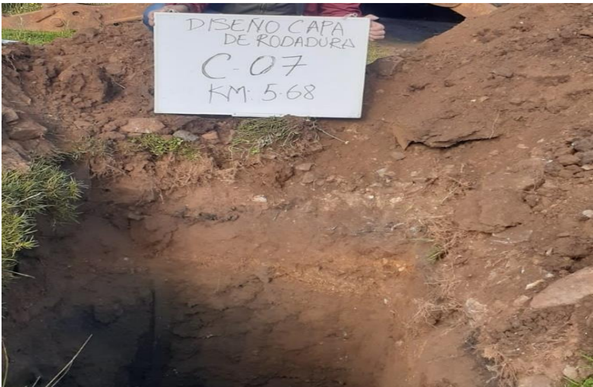
fotografía 28: Excavación de calicata 7
