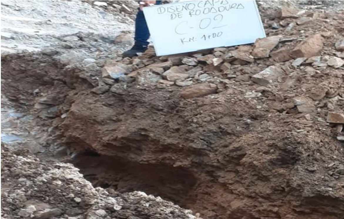
Fotografía 23: se puede apreciar que se excavó a una profundidad de 1.55m, cumpliendo con lo establecido con la normatividad vigente.
