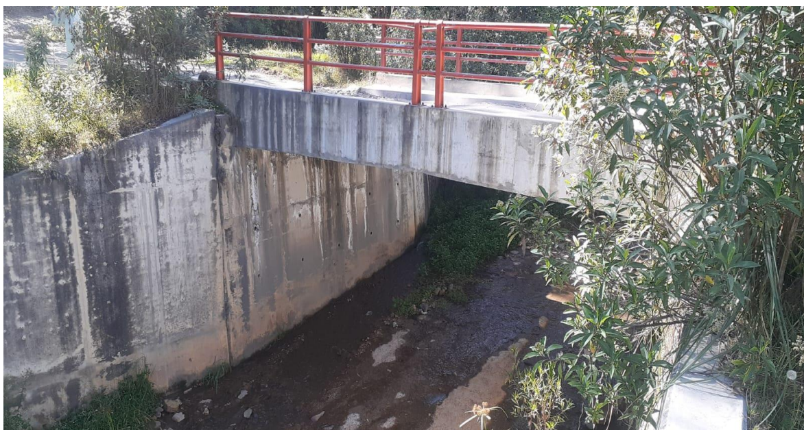
Anexo 78: Imagen de los estribos del puente
