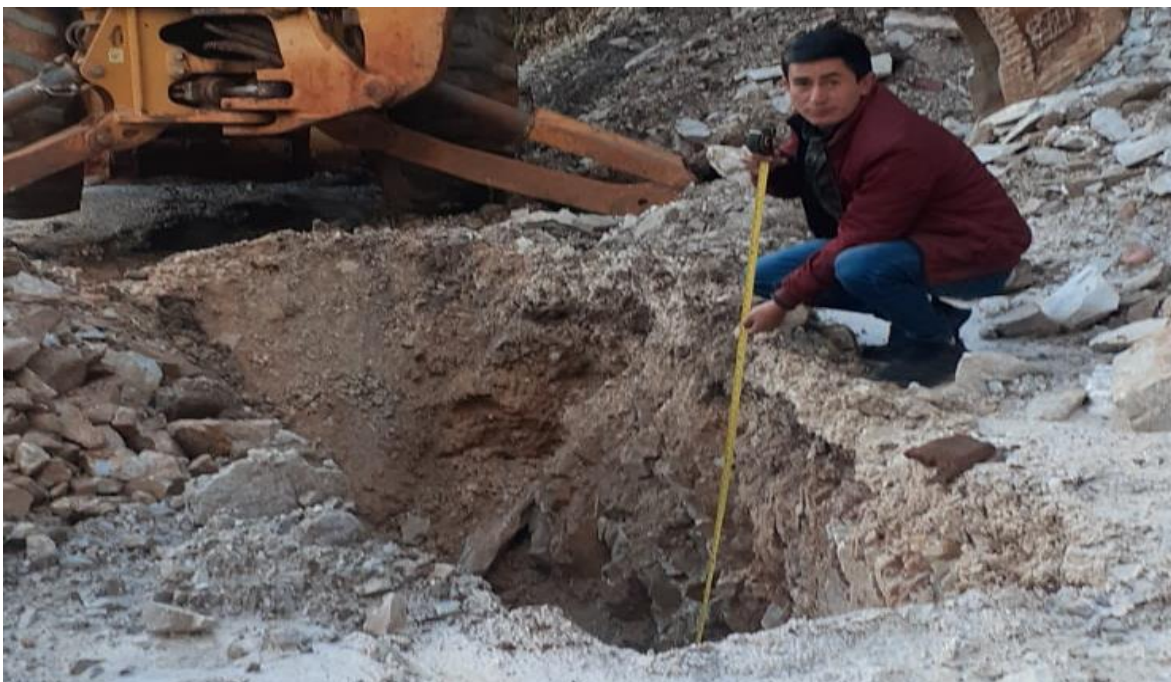
Fotografía 22: se aprecia la medición de la profundidad de la calicata que fue de 1.55m cumpliendo con lo establecido por la noma.
