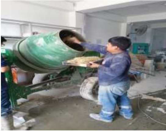
Fotografía 13. Adición de la fibra de ichu al concreto
