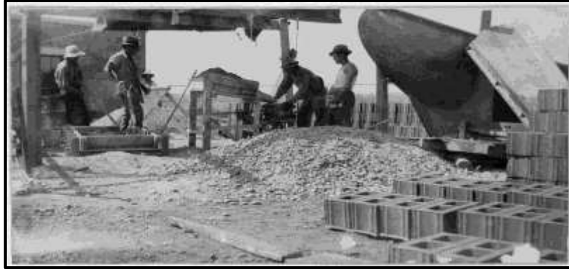
Figura 7. Preparación de mezcla de concreto Fuente: https://bit.ly/3lxomVx
