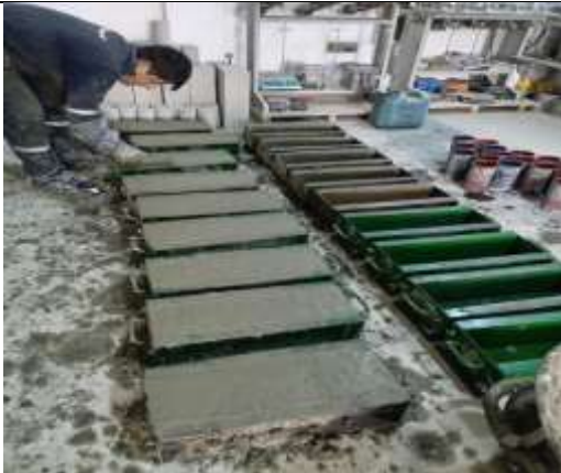
Fotografía 15. Elaboración de probetas y vigas
