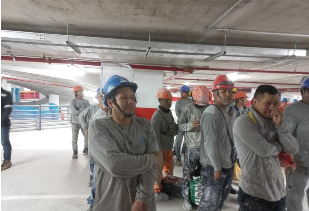
Figura 15. Inspecciones de SST
