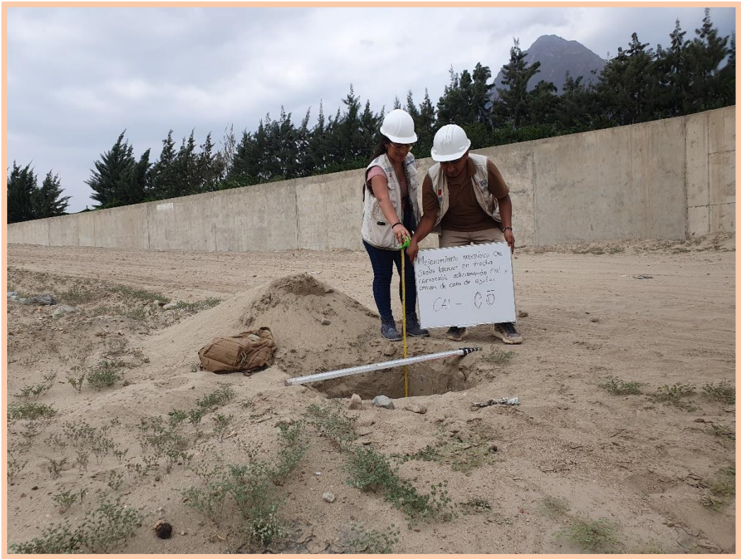
Realización de Calicatas en el km 15+000
