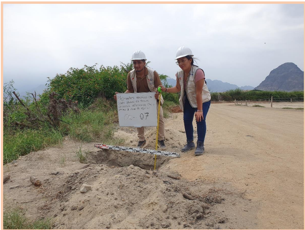
Realización de Calicatas en el km 16+000
