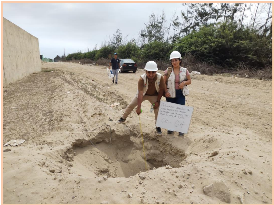
Realización de Calicatas en el km 14+500
