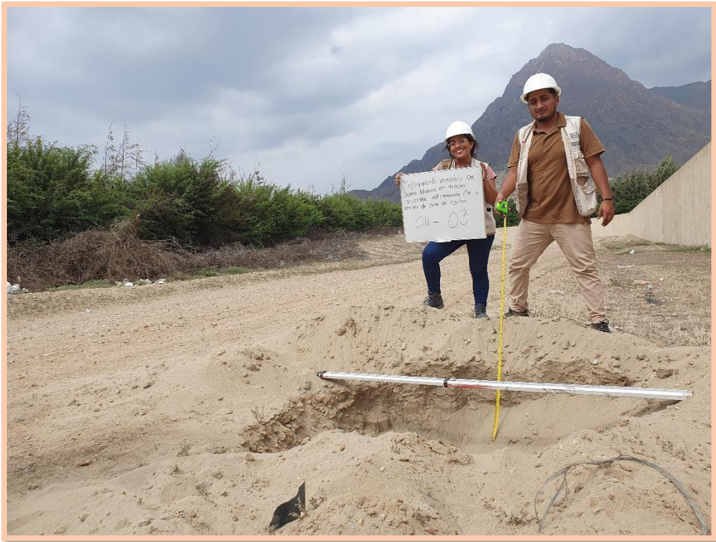
Realización de Calicatas en el km 14+000
