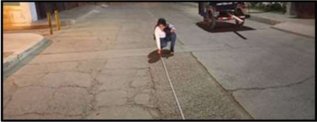
Pavimento Dañado: - Piel de Cocodrilo.
