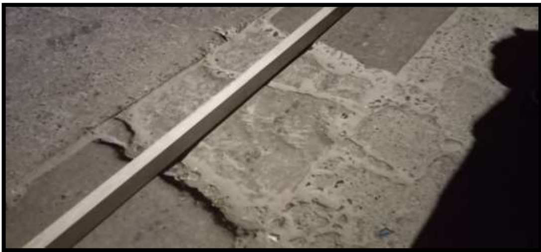
Pavimento Dañado: - Piel de Cocodrilo.
