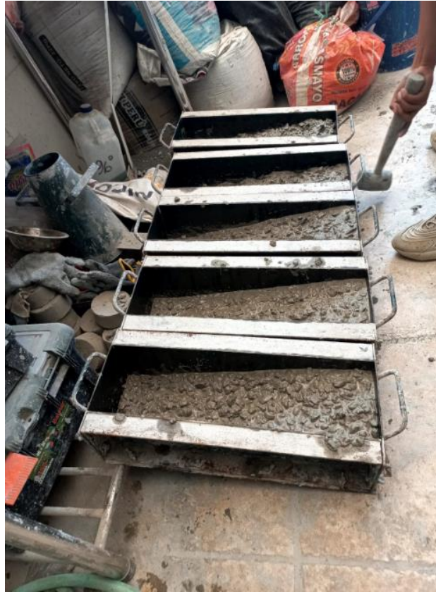
Figura 18. Vaciado de mezcla en los moldes de vigas.
