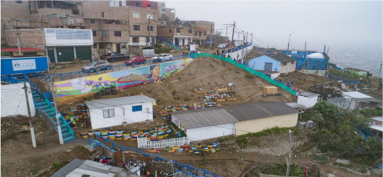
Figura 1. Recuperación del AA.HH. Bello Horizonte.
