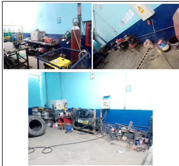
Figura 25: Colocación de Tarjeta roja en taller de Llantería, soldadura y mecánica
