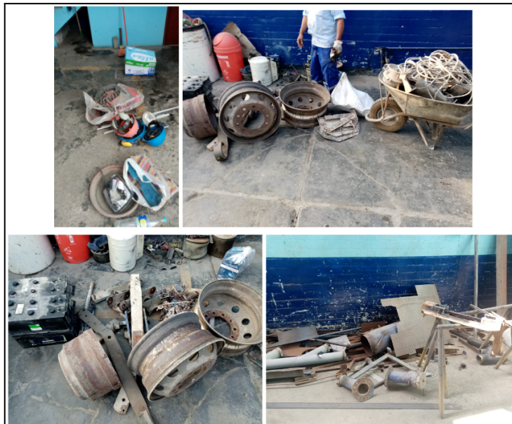
Figura 31 : Realización de la limpieza
