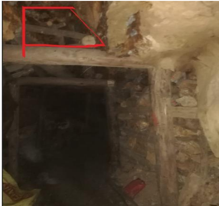
Figura 10. Sobre excavación. Fuente: Elaboración propia.
