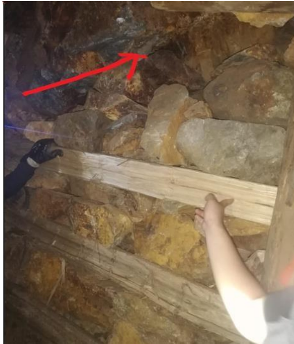
Figura 11. Sobre excavación. Fuente: Elaboración propia.
