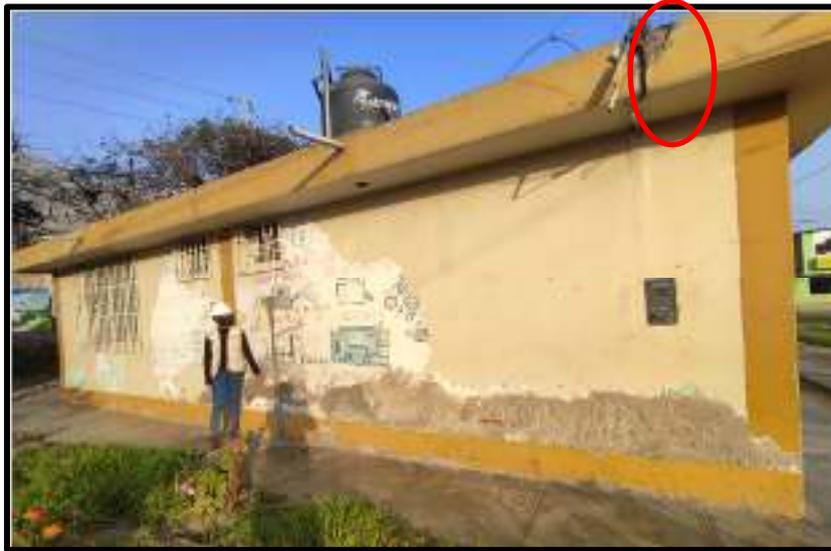
Anexo 8: Muro de posta de salud en estado deteriorado por presencia de humedad, también se observa en la parte superior donde se ha realizado un picado vertical para el paso de tubería de agua proveniente del tanque elevado.
