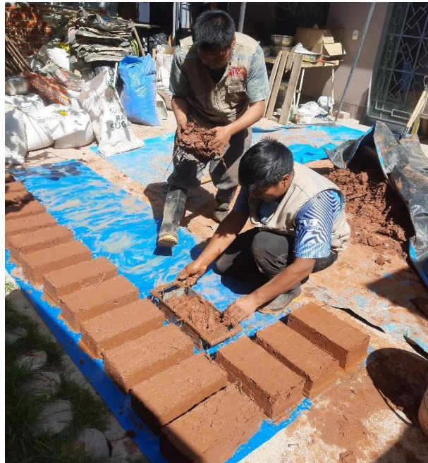
Figura 18. Elaboración de las unidades de adobe. Fuente: Elaboración propia
