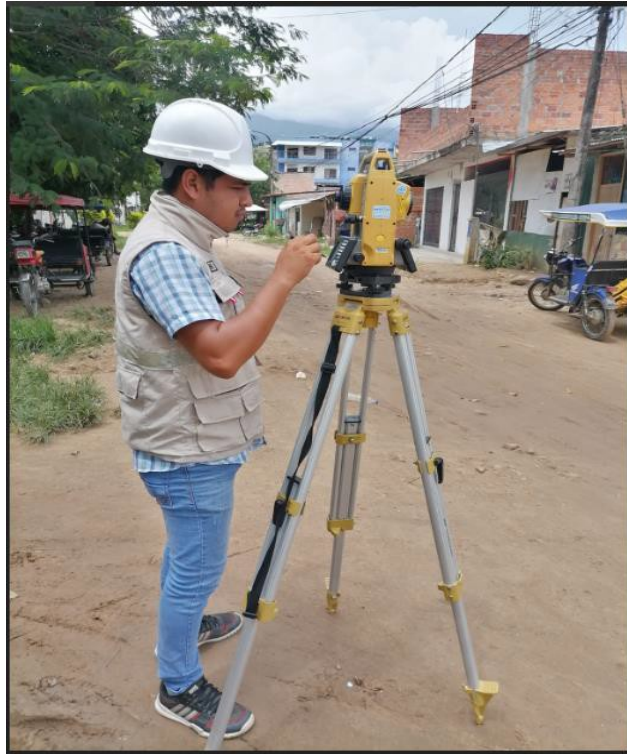
Foto 03: Realizando nivelación del Jr. José Olaya Cuadra 06
