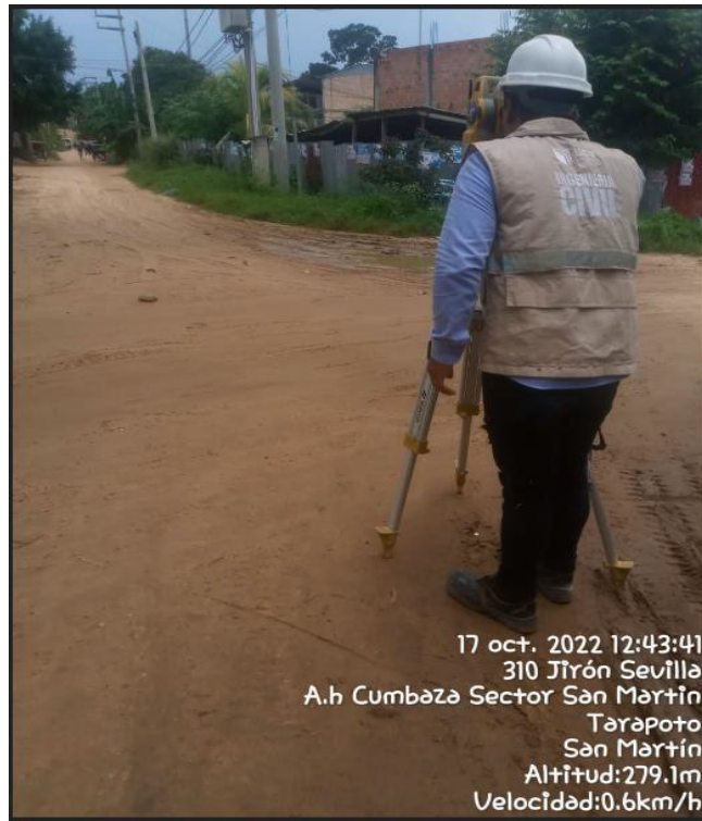
Foto 02: Realizando nivelación del Jr. Jose Olaya Cuadra 06
