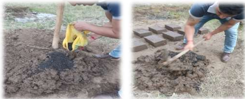
Figura 19 mezclado del asfalto bituminoso con el barro
