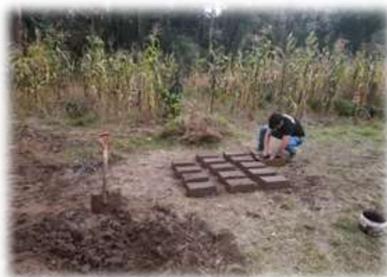
Figura 17 jalado de adobes patrones
