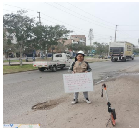
Imagen 4. UM-06 de evaluación de pavimento
