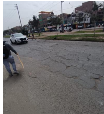
Imagen 28. Tránsito vehicular en pavimento flexible con huecos, piel de cocodrilo
